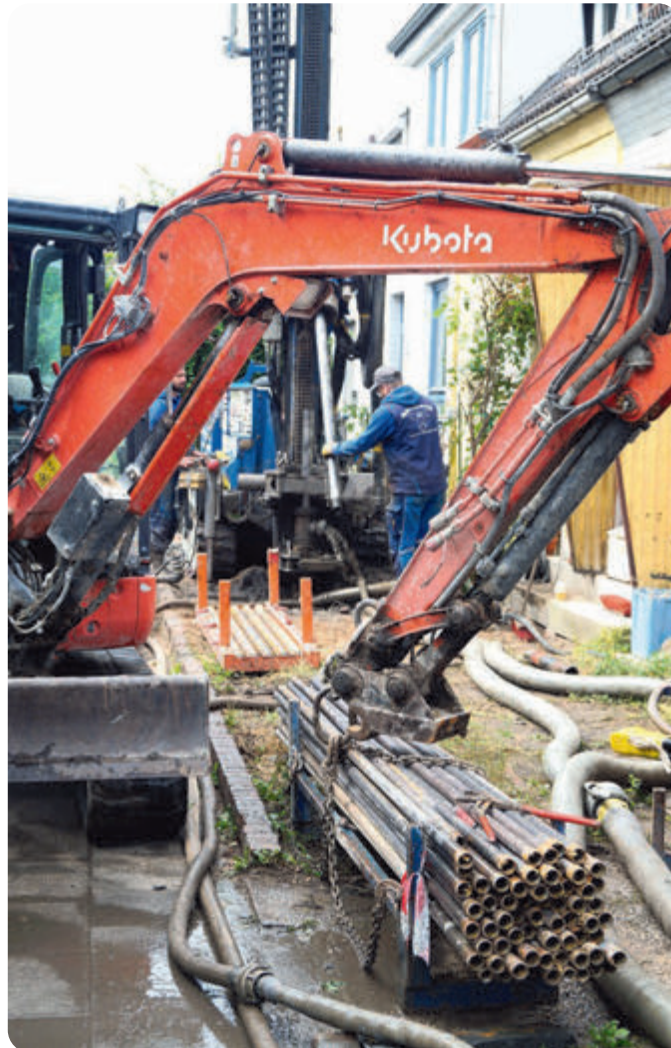
Nur mit sehr kompaktem Gerät war es möglich, in dem schmalen Garten die Bohrung vorzunehmen. FOTOS (3): ENERGIEKONSENS
