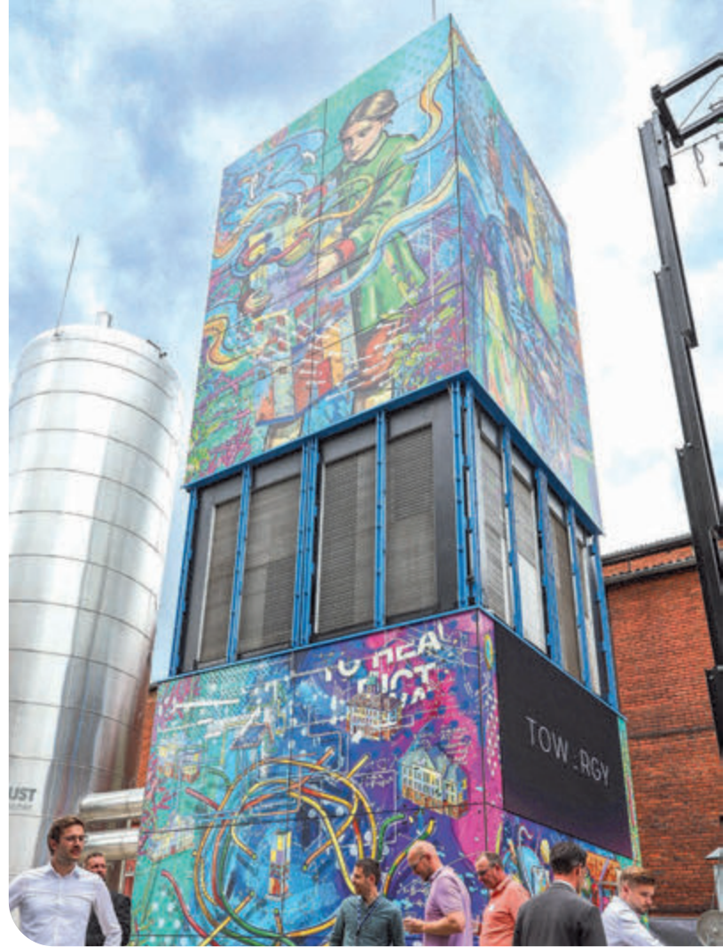
Der Klimaturm ist eine Großwärmepumpe auf der Überseeinsel und kann bis zu 400 Wohnungen im Neubau und 200 Wohnungen im Bestand versorgen.
