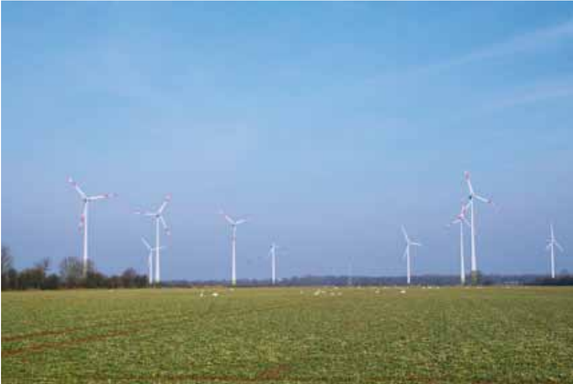
Am Windenergie-standort Mahndorf wurden 2011 fünf zusätzliche Anlagen mit einer Leistung von jeweils 2,3 Megawatt errichtet
