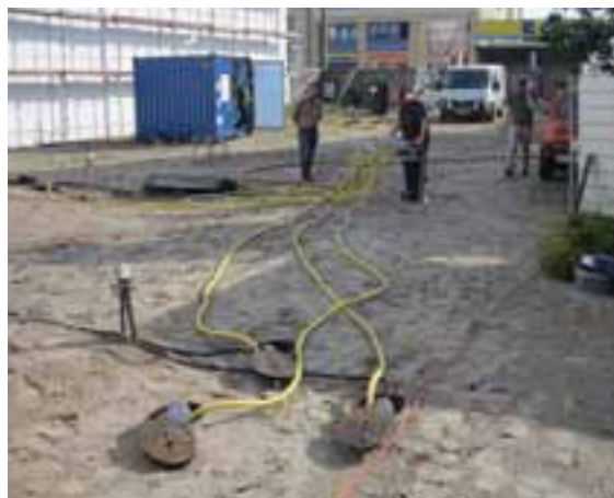
Sanierung in situ: Verteilung der angelieferten Melasse auf die einzelnen Infiltrationsbrunnen
