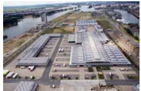
Eine Gesamtleistung von 1 Megawatt peak steuert die Photovoltaikanlage auf dem Großmarkt Bremen bei.
