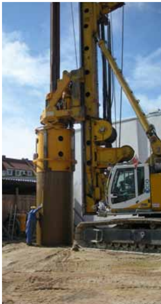
Das Großbohrgerät im Einsatz
