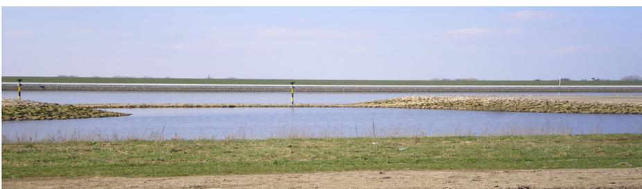
Überlaufschwelle sichern das Einströmen der Tide bei steigenden Wasserständen und gleichzeitig das Leerlaufen der Flachwasserbereiche bei Niedrigwasser
