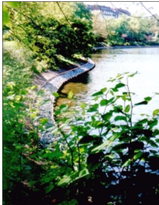
Klare Uferlinie (bei abgesenktem Wasserspiegel in Bauphase, Mai 1999)
