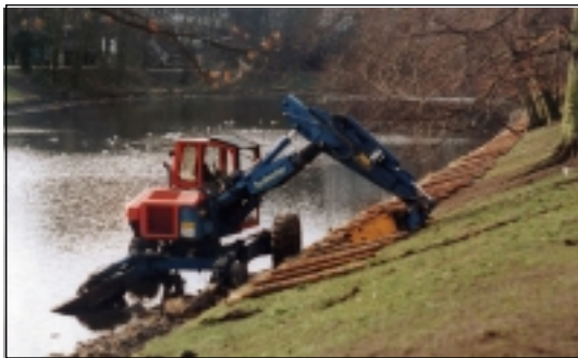
Erneuerung der Uferbefestigung (März 1999)
