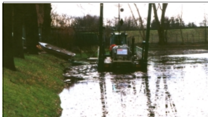
Baggararbeiten in der Rottkuhle im Sommer 1998
