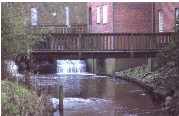
Das Wehr am Schloss mit seinem zwei Meter hohen Absturz blieb bei der Maßnahme unverändert bestehen
