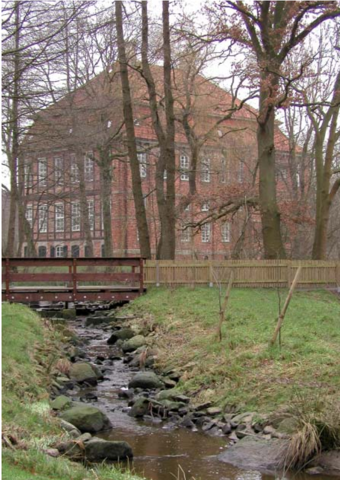
Die Fundamente des Schönebecker Schlosses bleiben durch die 2006 fertiggestellte Maßnahme unbeeinträchtigt
