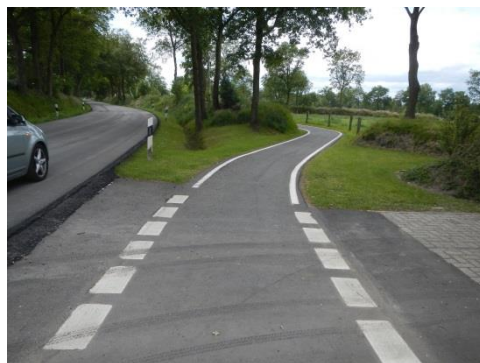
Bild 4-30 Randmarkierung zur Verdeutlichung der Linienführung (Außerortsstraße bei Jever)
