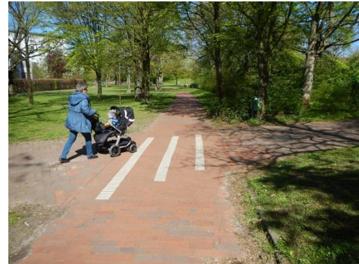
Bild 7-3 Beispiel Utbremer Grün: Materialwechsel zur Betonung einer Querungsstelle mit dem Fußverkehr.
