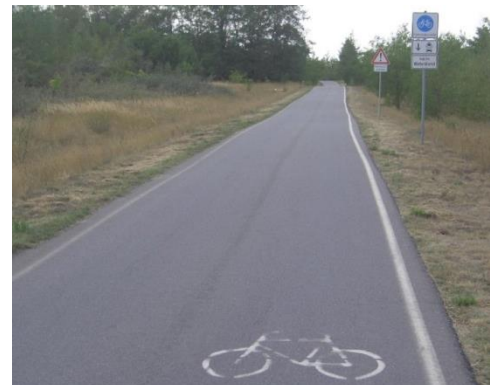
Bild 7-21 Fahrradstraße auf einer Außerortsstraße in Brandenburg
