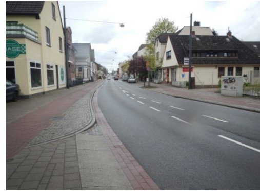
Bild 7-5 Geringes Verbreiterungspotenzial für die Radwege in der Burger Heerstraße auf kurzem Teilstück
