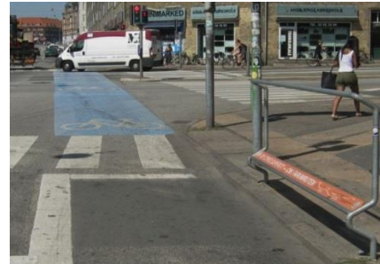
Bild 4-37 Trittbrett an einer Lichtsignalanlage (Kopenhagen)
