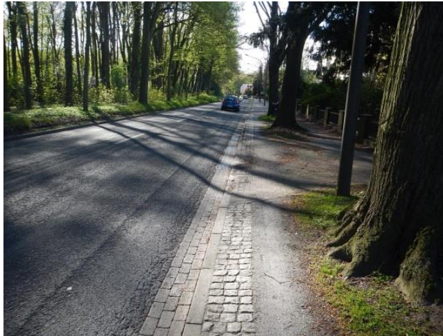
Bild 7-6 Lindenstraße: Radwegengstelle durch Baumbestand, die durch einen Schutzstreifen ersetzt wird
