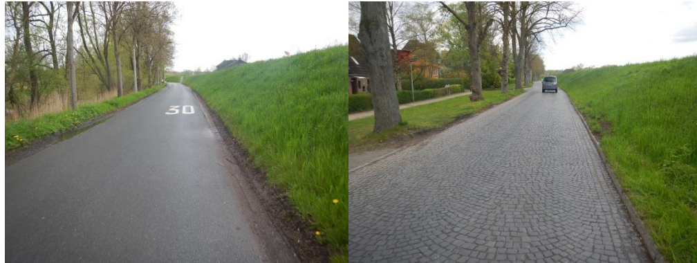
Bild 7-18 Lesumbroker Landstraße: innerörtliche Straße mit außerörtliche rCharakteristik und Tempo 30.
