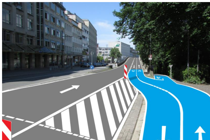
Bild 7-44 Führung der Premiumroute vom Radweg Am Wall auf die Hochstraße (Fahrrichtung Westen)
