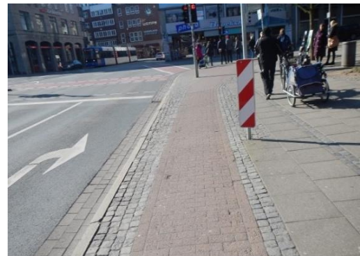
Bild 7-46 Am Wall/Herdentor: Nördlicher Aufstellbereich, Fahrtrichtung Herdentor zur Sögestraße. Der Rechtsabiegestreifen wird zukünftig entfallen und kann als Radfahrstreifen genutzt werden.
