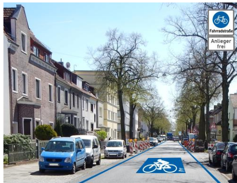
Bild 4-38 Standardgestaltung einer Fahrradstraße im Zuge einer Premiumroute
