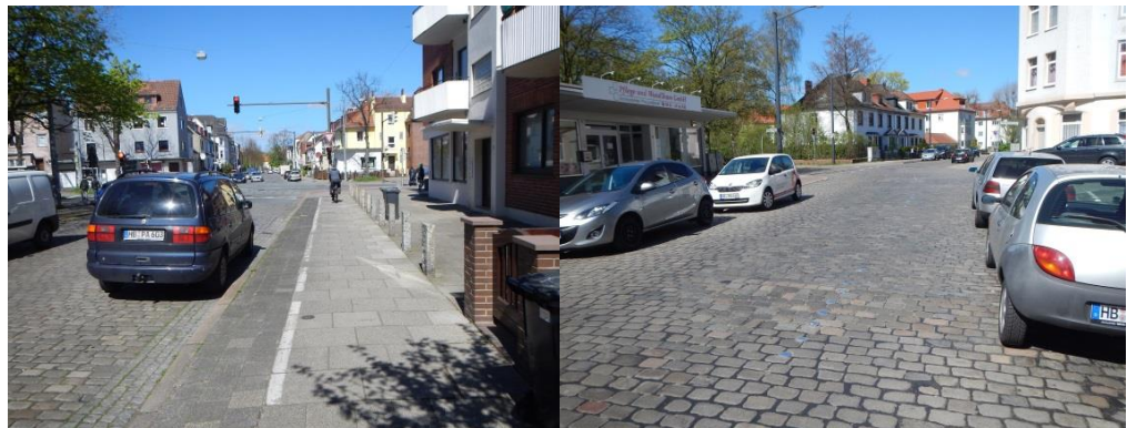
Bild 7-26 Lange Reihe: Heutiger Zustand mit schmalen Radwegen und gepflasterter Fahrbahn
