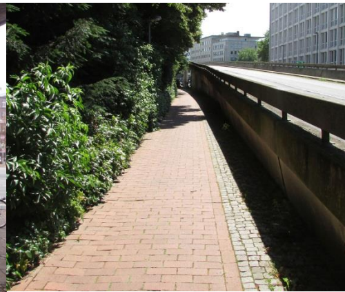
Bild 7-39 Am Wall: Beengter Radweg entlang der Rampe zur Hochstraße.
