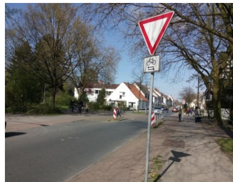
Bild 7-25 Bevorrechtigter Radweg im Zuge des Grünzuges West mit Aufpflasterung über Schwarzer Weg.
