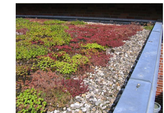
extensive Dachbegrünung auf EFH 1-3, Carports RH 1, Carport II und Garagenhöfe II, III und IV
