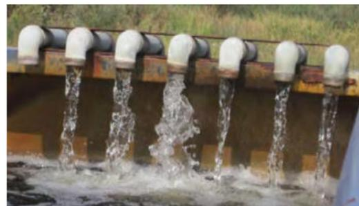
Abb. 01 | Einlauf von Grundwasser in die biologische Reinigungsstufe
