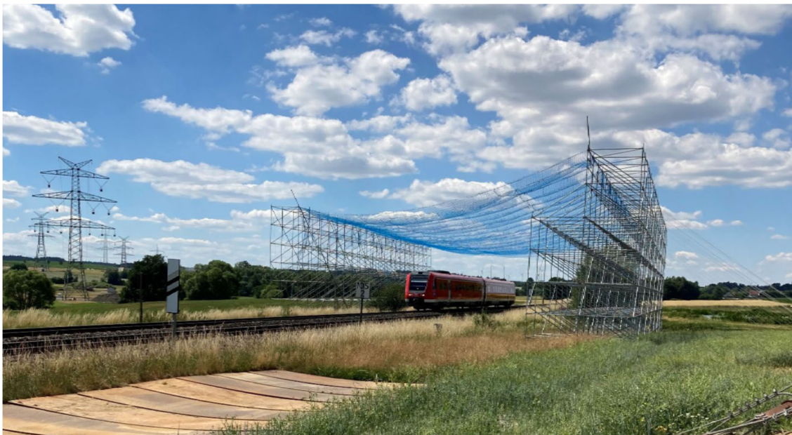
Abbildung 9: Beispiel für ein Schutzgerüst aus Stahl
