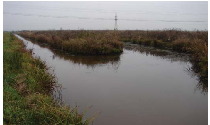
Der Oslebshäuser Piepengraben nach der Umsetzung der Maßnahme
