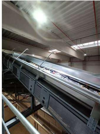
**Abbildung 20** Beispiel Sprühwasserlöschanlage Bänder
