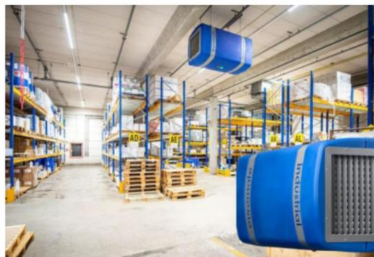
Abbildung 14: Beispiel zusätzlicher singulärer Filter
