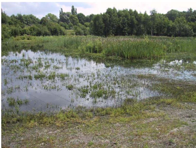
Foto 4: Regenrückhaltebecken Weißenstein in Bremerhaven
