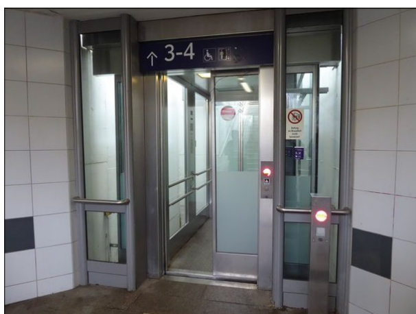
Abbildung 48: Der Aufzug zum Bahnsteig der Gleise 3/4 in Bremen-Burg war defekt.
