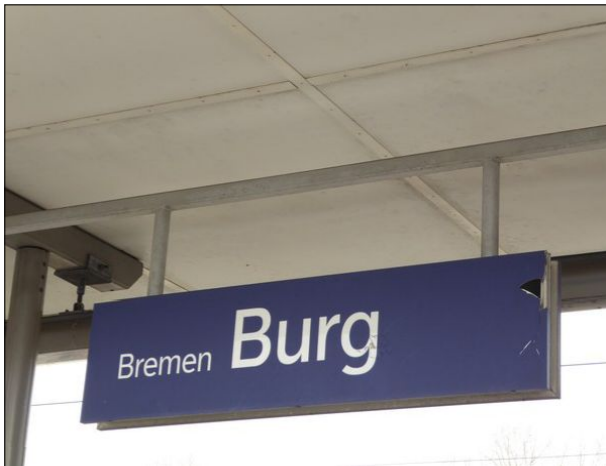
Abbildung 20: Ein Bahnhofnamensschild an Gleis 2 in Bremen-Burg war leicht beschädigt.
