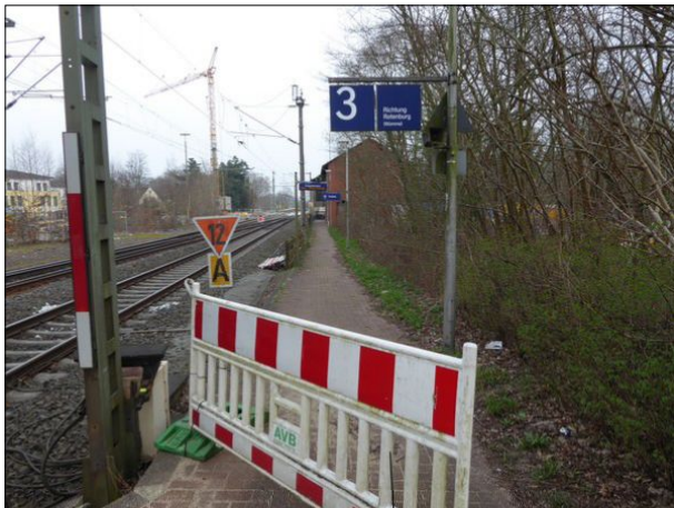
Abbildung 46: Durch die Sperrung des regulären Zugangs zu Gleis 3 in Bremen-Oberneuland ist der dort platzierte DSA vom Bahnsteig aus nur schwer zu erkennen.
