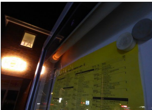
Abbildung 27: Die Leuchtstoffröhre in der Vitrine neben dem Fahrkartenautomaten in Bremen-Oslebshausen war defekt.
