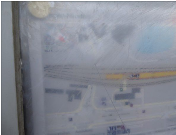
Abbildung 26: Die Vitrine auf dem Bahnsteig in Bremen-Neustadt war bereichsweise trüb. Die aushängenden Informationen waren nicht vollständig lesbar.
