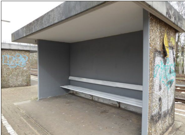
Abbildung 10: Die Bänke und die Innenwände der Unterstände in Bremen-Hemelingen wurden mit einer Grundierung auf den Neuanstrich vorbereitet. Die Graffiti auf den Außenwänden wurden noch nicht entfernt.
