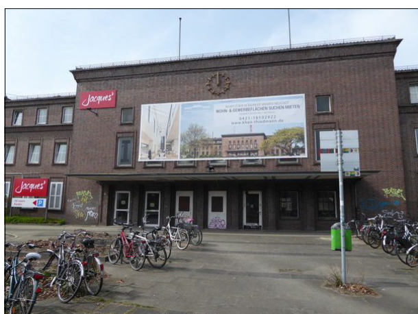
Abbildung 3: Nachdem der Zugang zum Bahnsteigtunnel in Bremen-Neustadt an die Seite verlegt wurde wartet das Bahnhofsgebäude auf neue Nutzungen.
