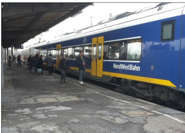
Abbildung 6: Ein barrierefreier Einstieg in die Züge wird in Bremen-Neustadt erst mit dem Anheben des Bahnsteigs auf das Niveau der Fahrzeugtüren möglich sein. Zudem ist der Bau eines Aufzugs erforderlich, um den Bahnsteig stufenlos zu erreichen.
