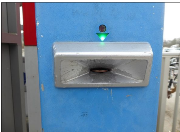
Abbildung 33: Der Entwerter an Gleis 1 in Bremen-Mahndorf war durch eine in den Schlitz gestopfte Münze nicht nutzbar.
