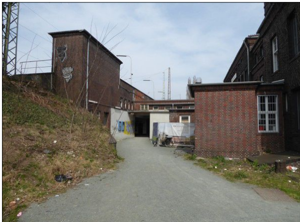
Abbildung 34: In Bremen-Neustadt ist der Zugang in den Bahnsteigtunnel unscheinbar. Zudem ist er von Abfall gesäumt.
