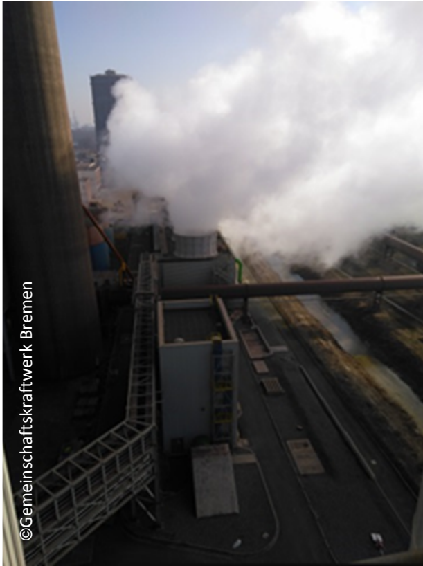
Abb. 2: Großer Verdunstungskühler in Bremen
