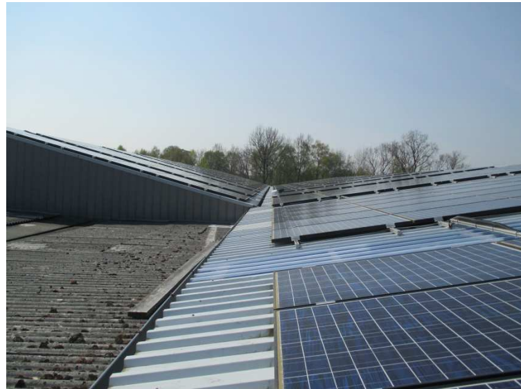
Abb. 1: Zugang zum Arbeitsbereich der Dachdecker
