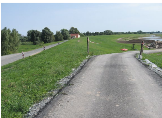
Nach der Fertigstellung
