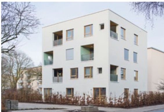
Systembau aus Holz in der Gartenstadt Süd: Neubau der GEWOBA im KfW-Effizienzhaus-Standard 55
