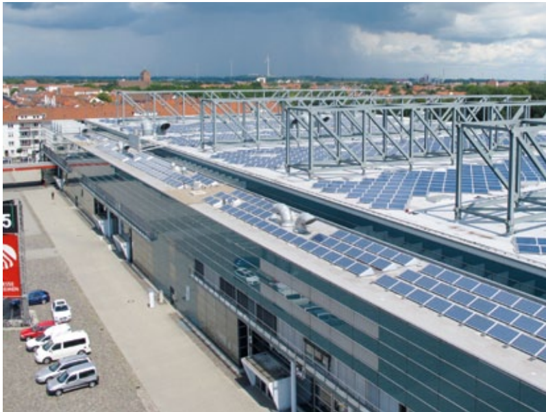
Photovoltaikanlage auf den Bremer Messehallen mit einer Leistung von rund 900 Kilowatt
