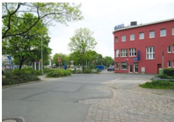
Ulmenstraße/ Kaistraße: vor dem Umbau
