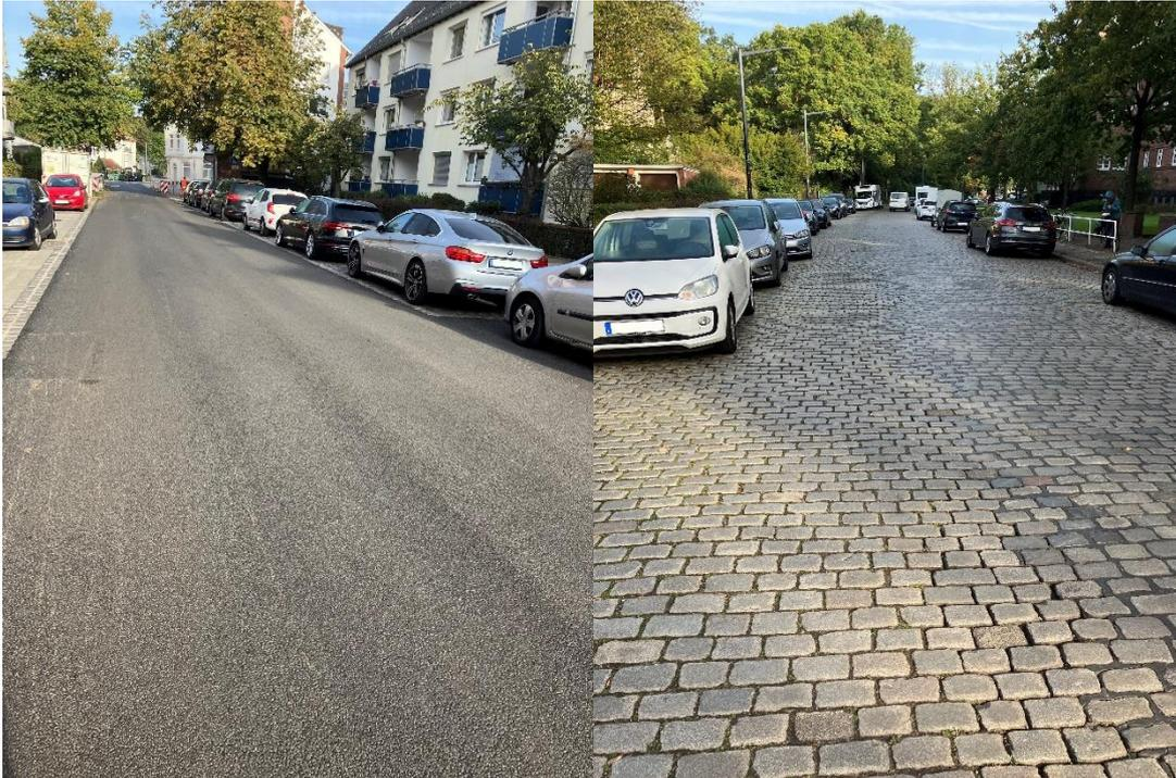
Abbildung 2: Bilder des bereits fertiggestellten 1. Bauabschnitts (BA) (links) und des noch nicht begonnen 2. BA (rechts) in der Langen Reihe
