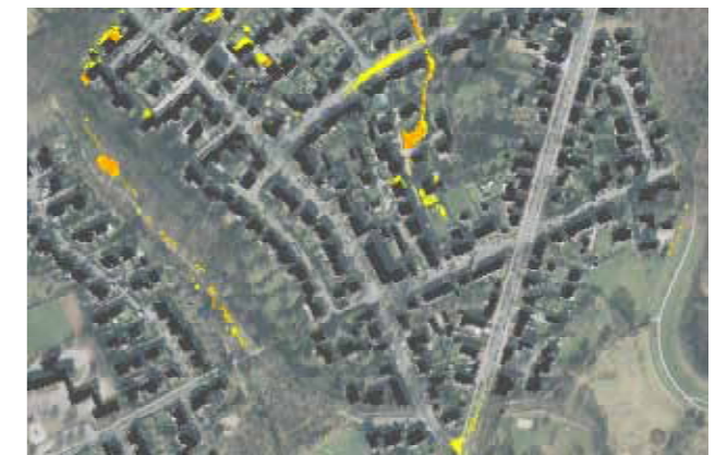
Abb. 28 Darstellung der maximalen Wasserstände aus der Simulation der Überstauausbreitung (gelb: > 0,10 m, orange > 0,25 m; Hintergrund: Orthofoto)
