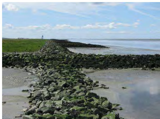
Abb. 17: Uferbefestigung an der Wurster Küste bei Dorum-Cappel-Neufeld
