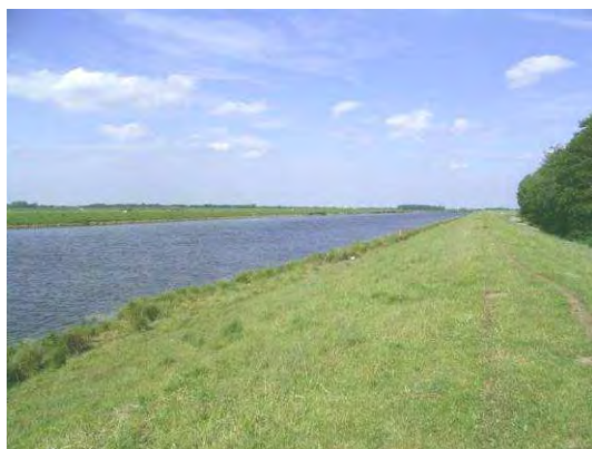
Abb. 11: Unterlauf der Hunte im Bereich des kanalartigen Ausbaus
