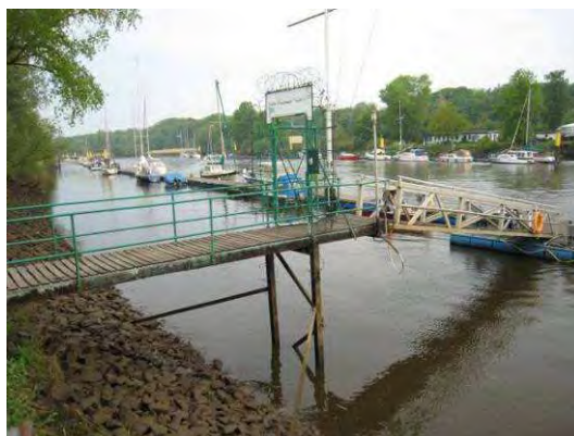
Abb. 29: Sportbootanleger am südlichen Lesum-Ufer; Steinschüttung zur Ufersicherung
