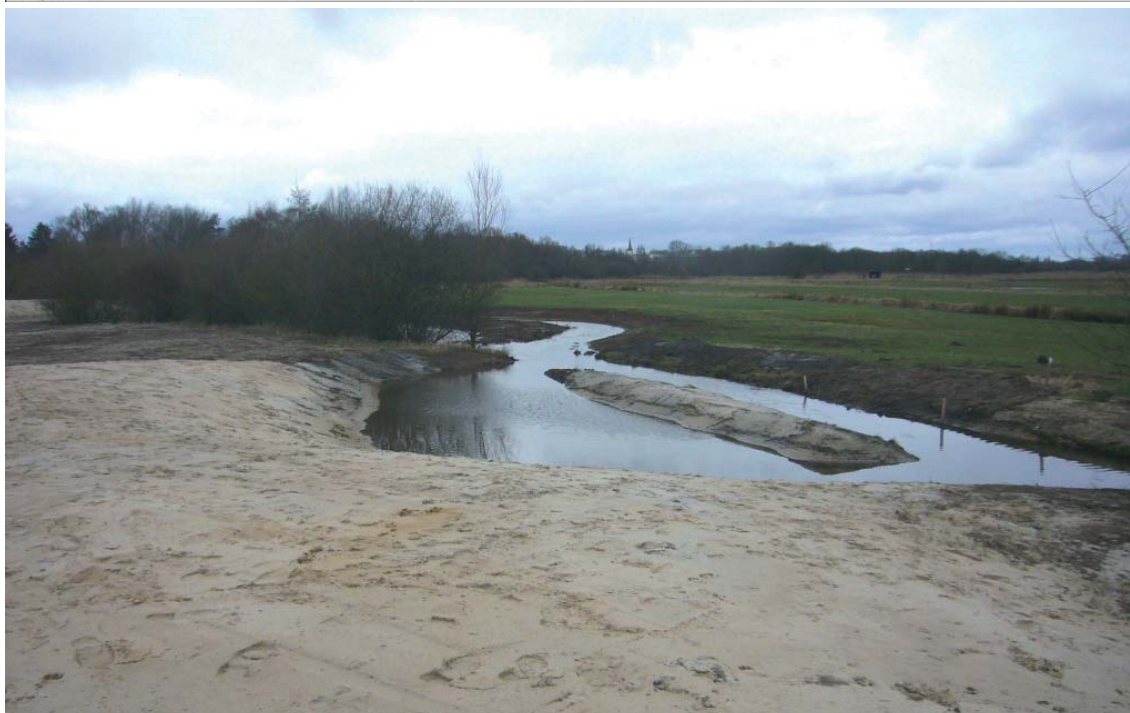
Die Maßnahme während der Bauzeit im Frühjahr 2012
