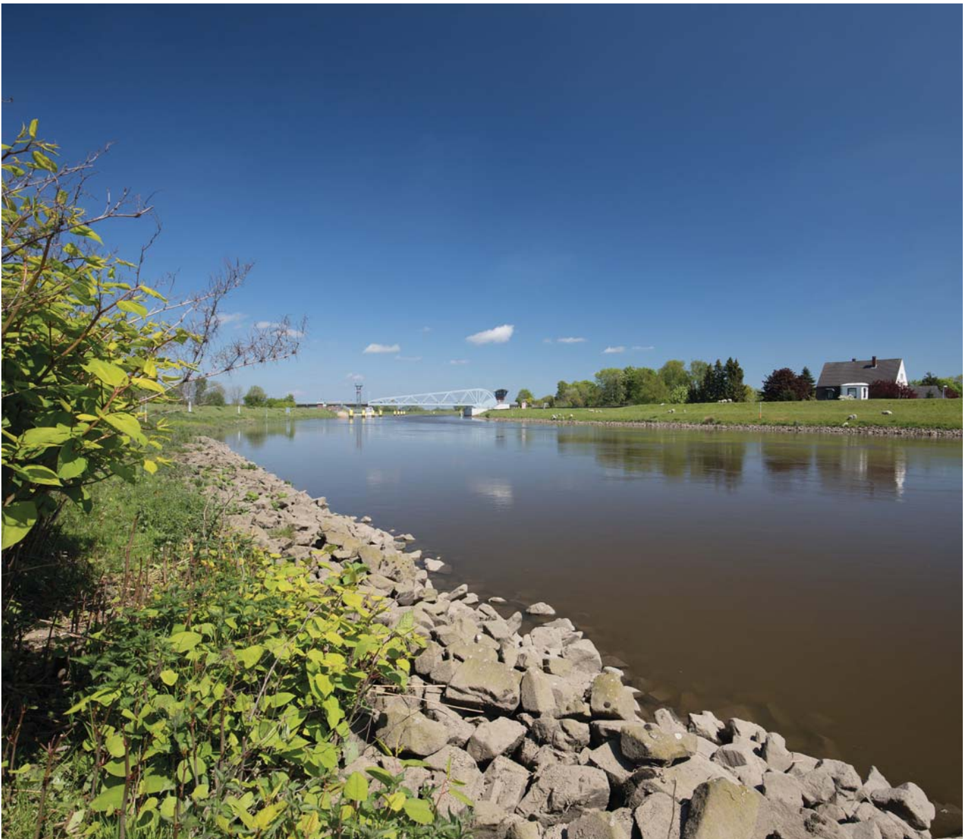
Abb. 6-5: Ufersicherung an einem scharliegenden Schutzdeich
