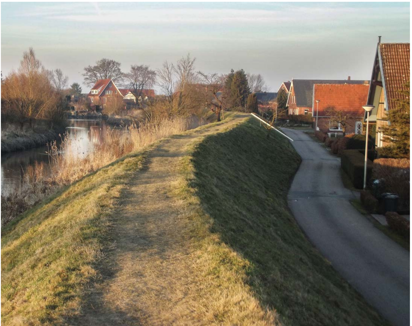
Abb. 2-4: Schutzdeiche an der Lühe
