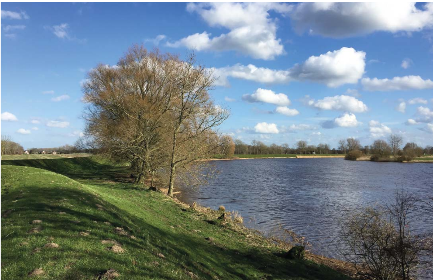
Abb. 1-4: Schutzdeiche an der Oste
