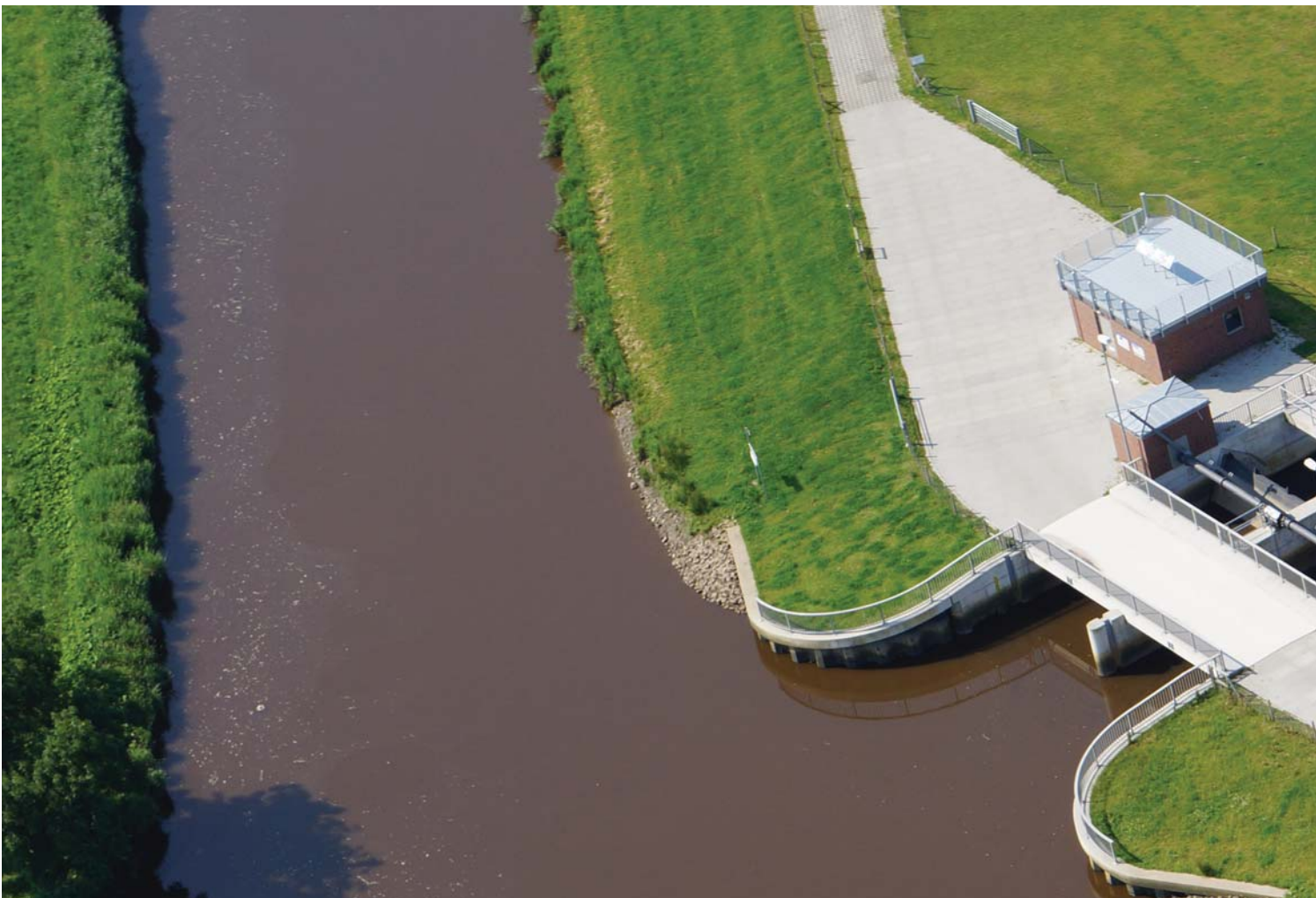
Abb. 6-2: Einlassbauwerk am Flutpolder Holter Hammrich
