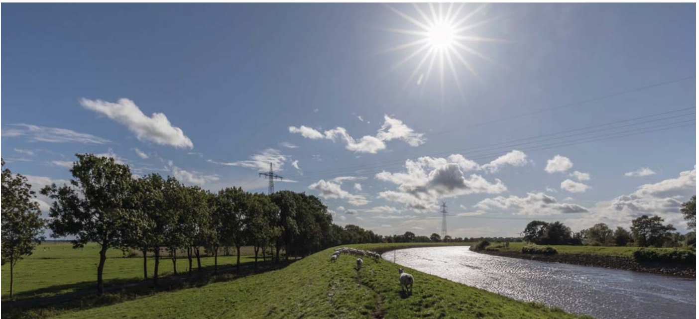
Abb. 2-2: Schutzdeiche an der Hunte unterhalb von Oldenburg
