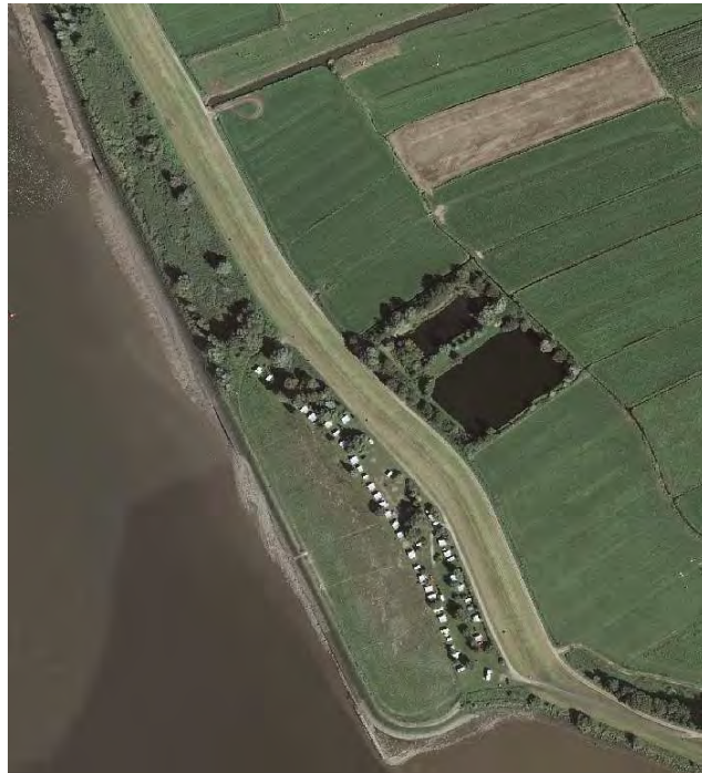
Abbildung 131: Teil des Deichabschnittes zwischen Reikum und Neuenkirchen; potenzieller Standort für Rückdeichungsmaßnahmen
