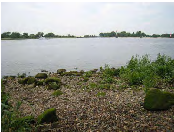
Abbildung 129: Ufersicherung durch Steinschüttungen im Funktionsraum 3 zwischen Blumenthal und Farge oben links: vergossenes Deckwerk; oben rechts: beginnender Bewuchs in unvergossenem Deckwerk unten links: teilweise aufgelöstes Deckwerk; unten rechts: unvergossenes Deckwerk mit artenreichem Bewuchs
