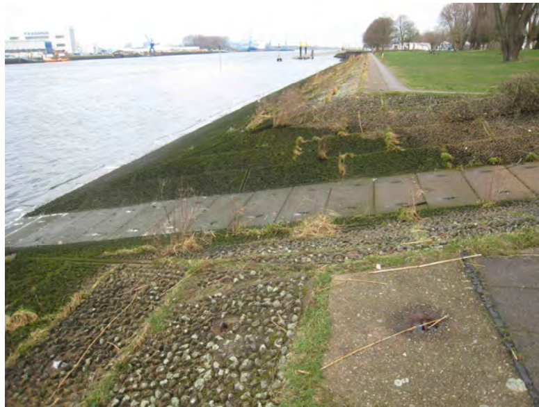
Abbildung 146: Uferbefestigungen im Bereich Bahrs Plate; im Hintergrund der Fährianleger
