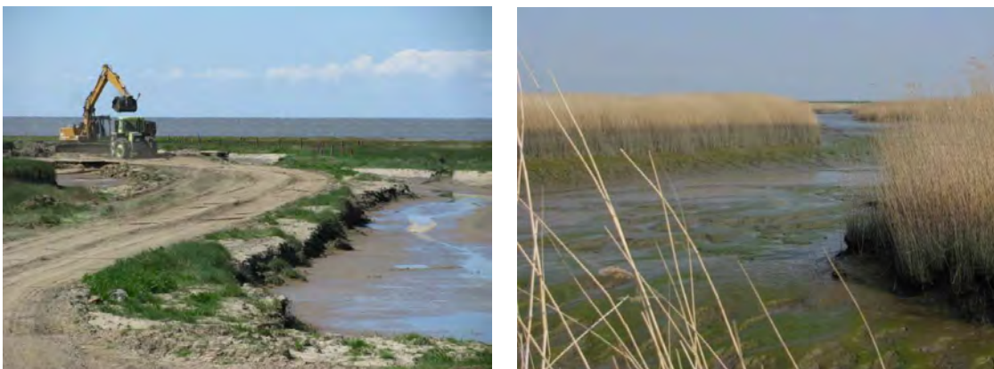
Abbildung 136: links: Bau des Prielsystems an der Wurster Küste; rechts: im Jahr 1996 hergestelltes Priel auf der Tegeler Plate
