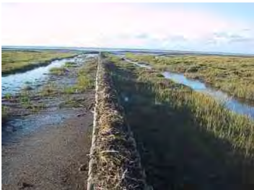
Abbildung 141: Lahnungsbau im Niedersächsischen Wattenmeer; links Buschlahnungen, rechts Steinlahnungen (NLWKN o.J.)
