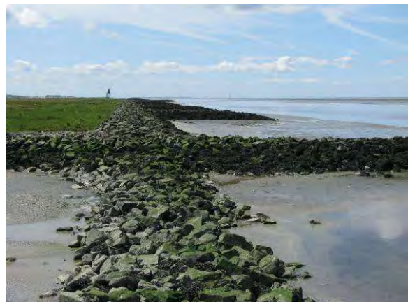
Abbildung 126: Absenkung des Deckwerkes im Lahnungsfeld im Rahmen von Maßnahmen zur Verstärkung des Tideeinflusses an der Wurster Küste
