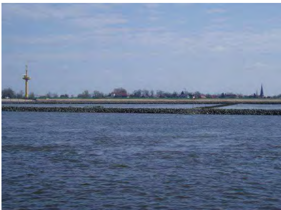
Abbildung 127: Vorlandsicherung durch Steinschüttungen links bei Sandstedt (FR 2); rechts bei Dorum-Cappel-Neufeld (FR 1)
