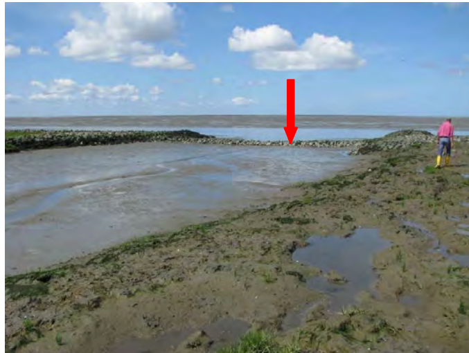
Abbildung 126: Absenkung des Deckwerkes im Lahnungsfeld im Rahmen von Maßnahmen zur Verstärkung des Tideeinflusses an der Wurster Küste
