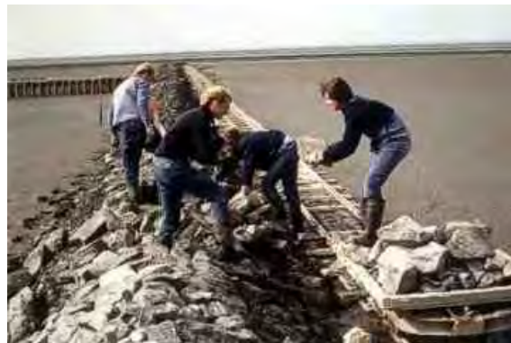
Abbildung 141: Lahnungsbau im Niedersächsischen Wattenmeer; links Buschlahnungen, rechts Steinlahnungen (NLWKN o.J.)
