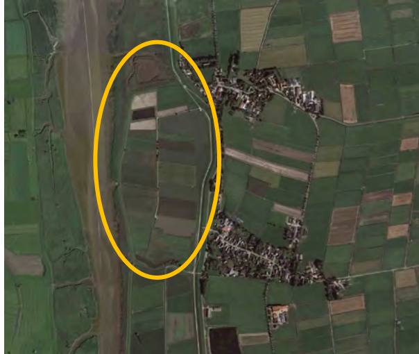
Öffnung des Sommerdeichs im Vorland von Offenwarden zur Anlage von Flachwasserzonen
