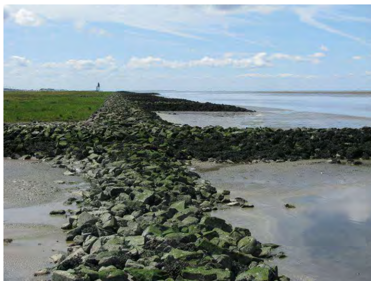
Abbildung 32: Uferbefestigung an der Wurster Küste bei Dorum-Cappel-Neufeld
