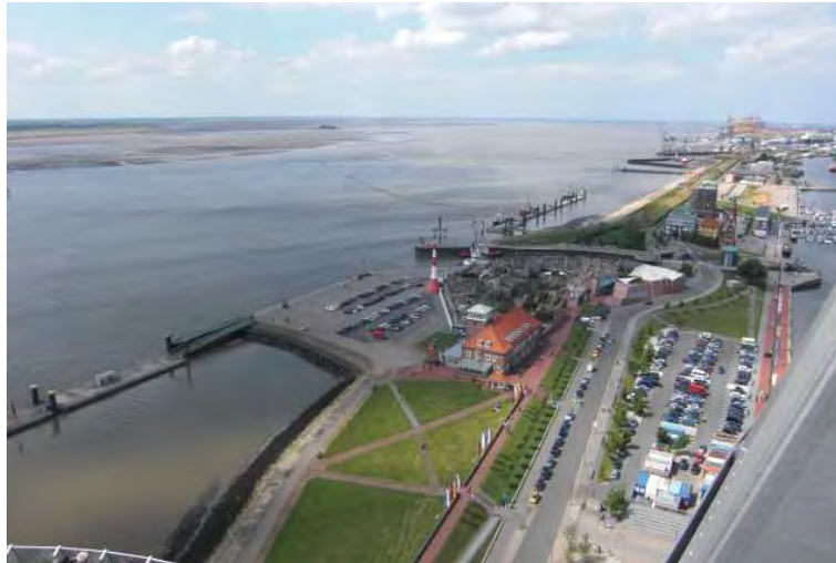
Abbildung 33: Blick von Bremerhaven in Richtung Norden zur Außenweser
