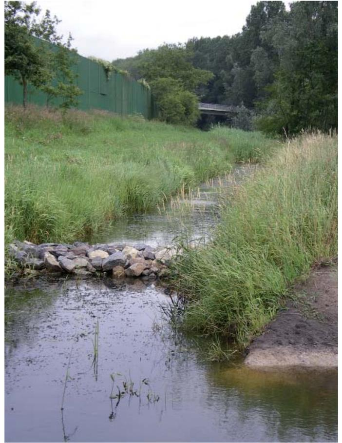
Der alte Verlauf wurde nach der Baumaßnahme mit Steinen abgegrenzt, so dass er nur noch bei hohen Abflüssen durchströmt ist. Unterstrom ist er offen an den Embser Mühlengrabens angeschlossen
