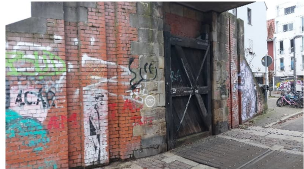
Abbildung 3: links: Deichschart Buntentor, Blick in den Buntentorsteinweg, rechts: Dammbalkennut und Holzdrehtor; Fotos: Sweco GmbH
