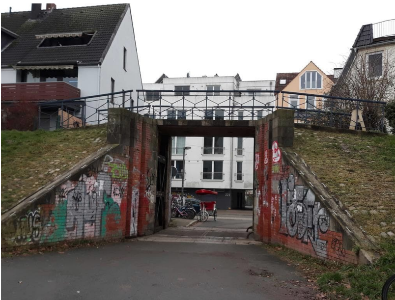
Abbildung 6: Deichschart Buntentor mit Brückenüberbau; Blickrichtung Neustadt
