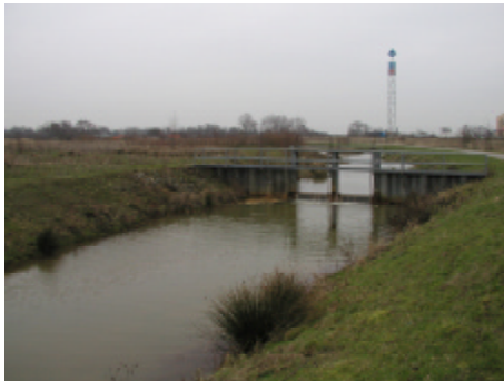
Foto: Der Stau im Arberger Kanal im Bereich der Baustufe I
