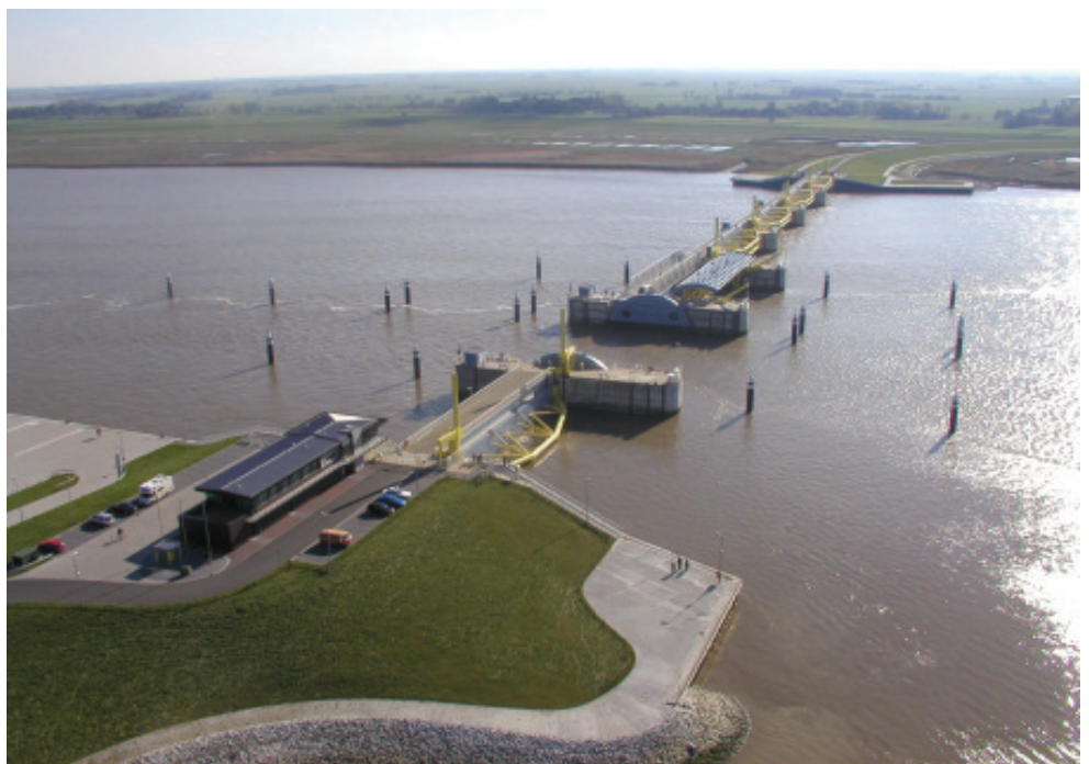
Abb. 3-1: Emswehrwerk zwischen Gandersum und Nendorp im Landkreis Leer (Quelle: NLWKN)
