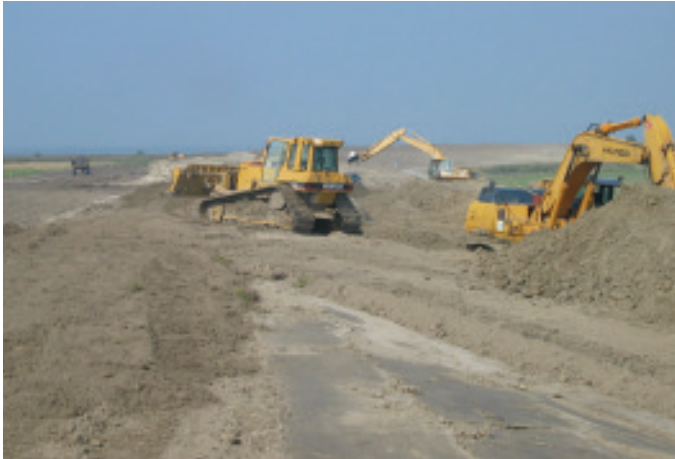
Abb. 5-2: Deichbaumaßnahme Rysum-Campen (Quelle: NLWKN)
