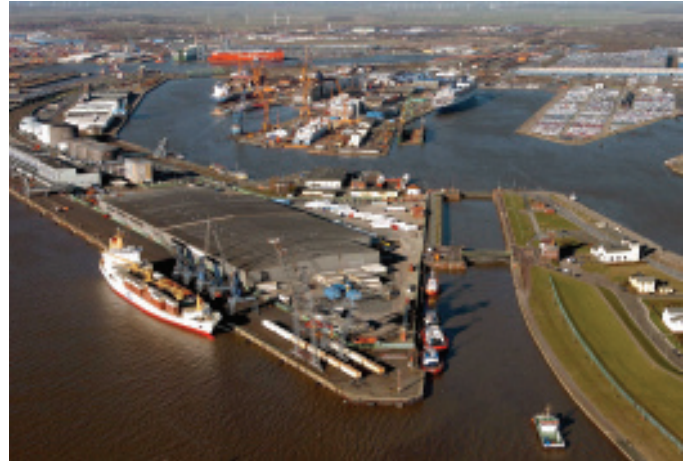
Abb. 5-7: Kaiserschleuse Bremerhaven (Quelle: bremenports)
