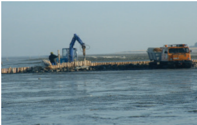
Abb. 5-6: Bau einer Lahnung mit Minibagger und Hägglunds-Fahrzeug (Quelle: NLWKN)
