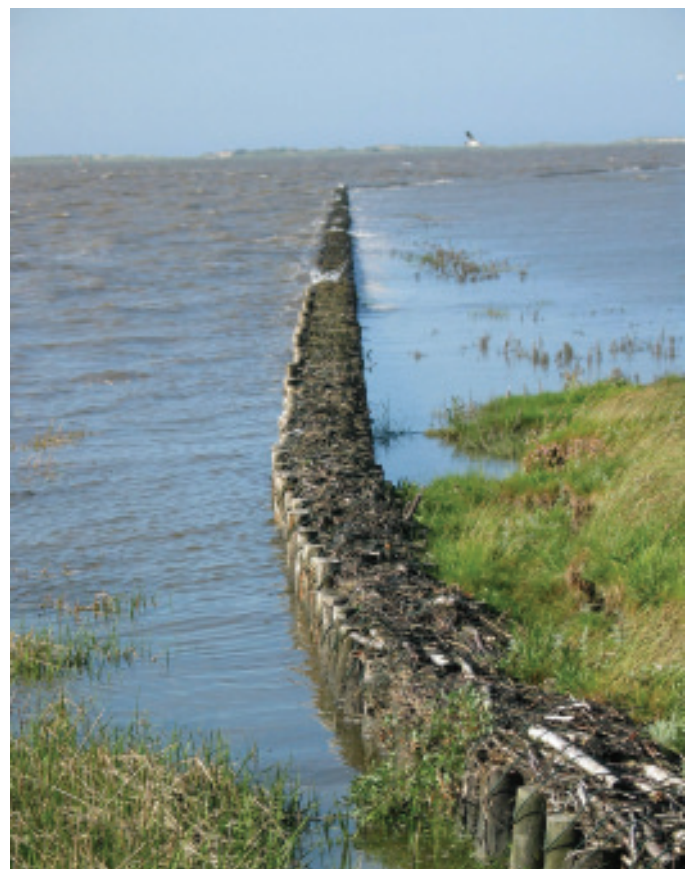
Abb. 5-5: Wirkung von Lahnungen (Quelle: Frank Thorenz)
