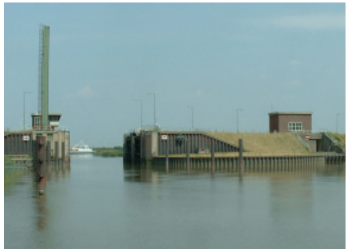
Abb. 5-3: Sperrwerk Wischhafen (Quelle: NLWKN)
