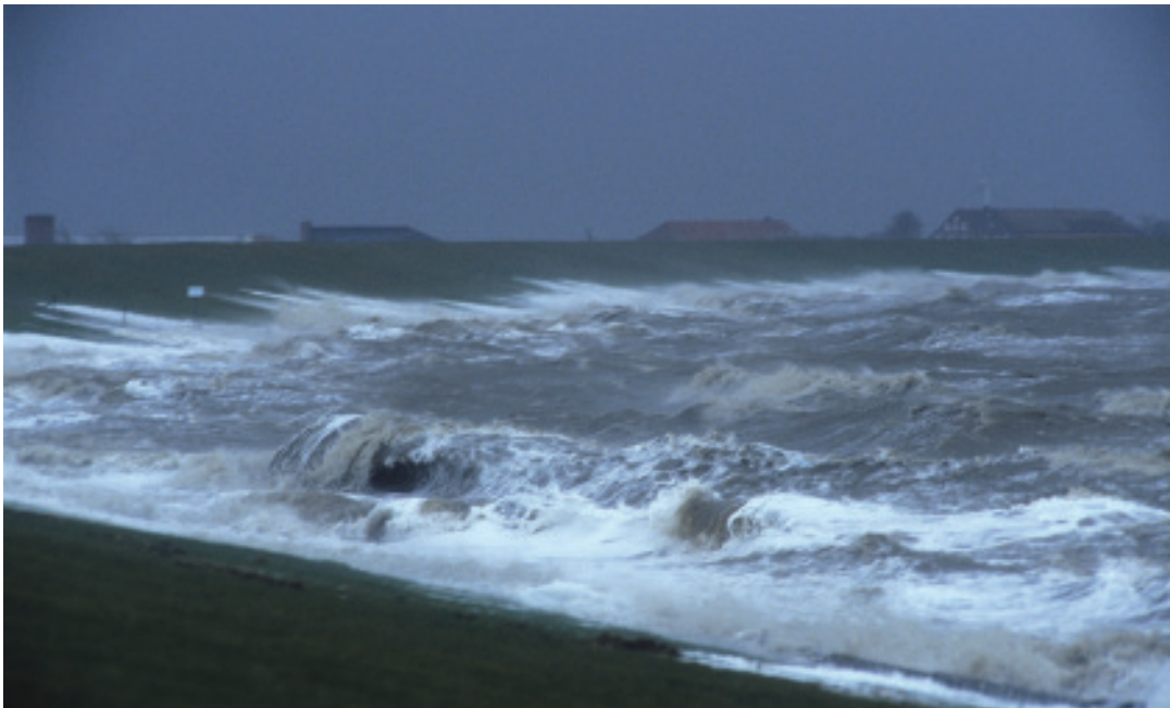
Abb. 7-1: Sturmflut am Hauptdeich (Quelle: Bild-SKN)
