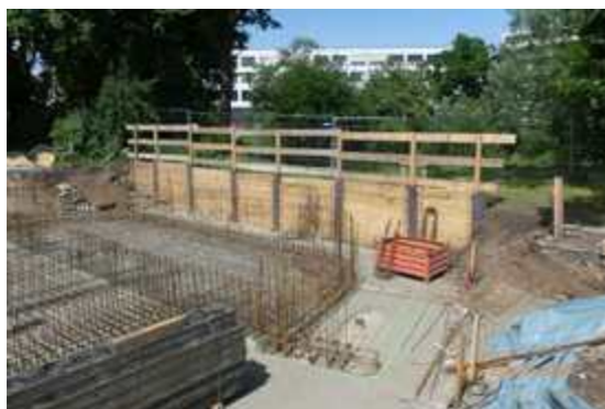
Unten: Ansicht der Baustelle im Bereich vor den Bäumen Nr. 29 und Nr. 30 (Abb. 9).
