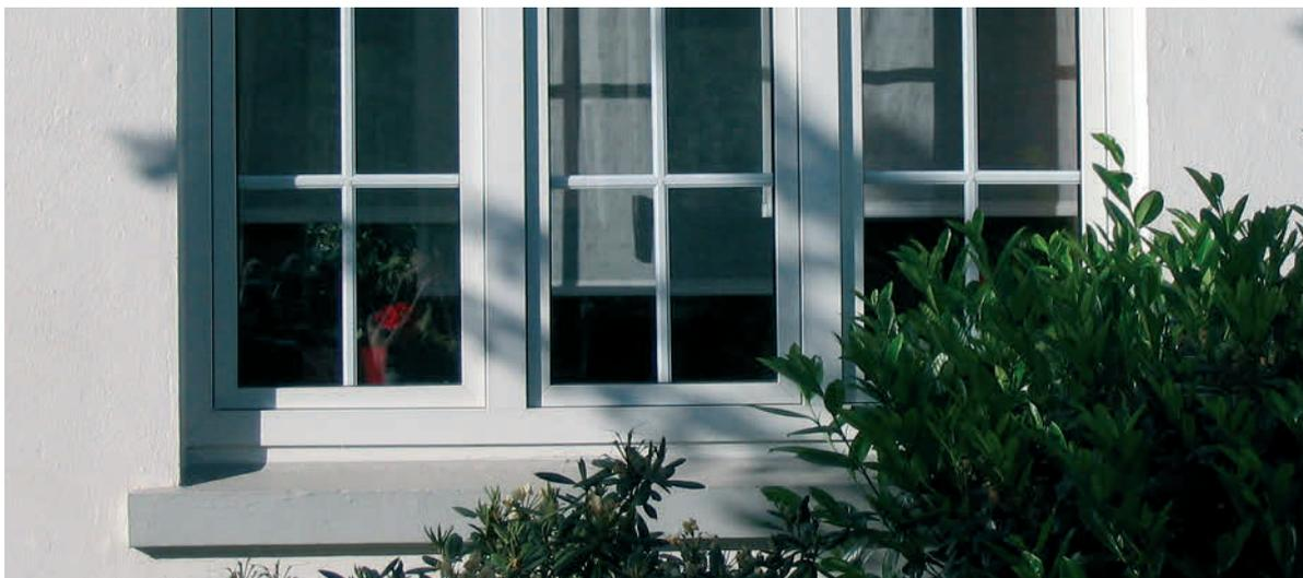
Das spezielle Fensterglas verringert die Einstrahlung entweder durch Absorption (Aufnahme) oder durch Reflexion (Zurückwerfen) des Sonnenlichts. Bei Absorptionsglas werden der Glasschmelze Farbstoffe - zum Beispiel Eisenoxid oder Kupferoxid - beige-mischt. Im sichtbaren und nicht sichtbaren Bereich reflektierendes Glas ist mit einem fest haftenden Film beschichtet. Oft werden hierfür Metallverbindungen hauchdünn aufgedampft.
