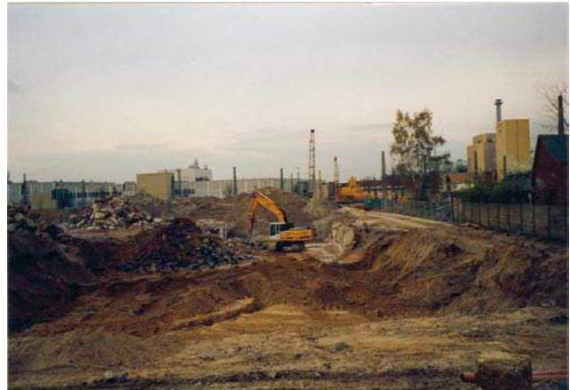
Abbildung 27: Altlastensanierung an der Diedrich-Wilkens-Straße
