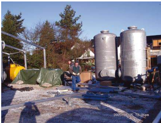
Abbildung 38: Aufbau einer Grundwasserreinigungsanlage Abbildung 39: Grundwasserreinigungsanlage von innen - Zu- und Ablauf
