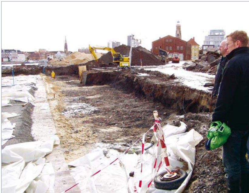
Abbildung 1: Sicherung einer Altlast am Neuen Hafen in Bremerhaven
