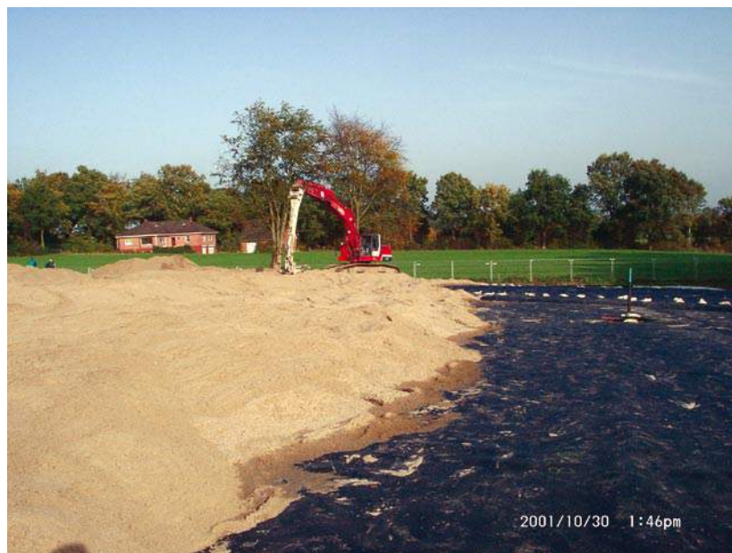
Abbildung 41: Sicherung einer Altdeponie durch Abdeckung mit Folie und Bodenaufbau
