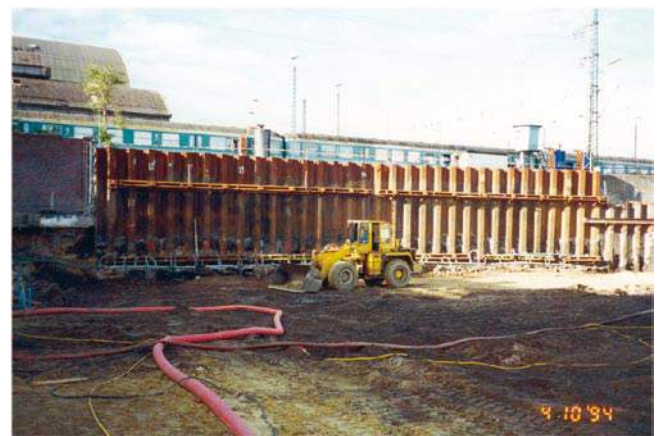
Abbildung 24 und 25: Altlastensanierung am Hauptbahnhof (Nordausgang) 1994. Am hinteren Rand der Baugrube sind die blauen Pegel der Anlage zur Grundwasserabsenkung sichtbar
