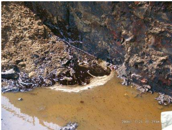
Abbildung 9: Teerölverunreinigung in einer Baugrube
