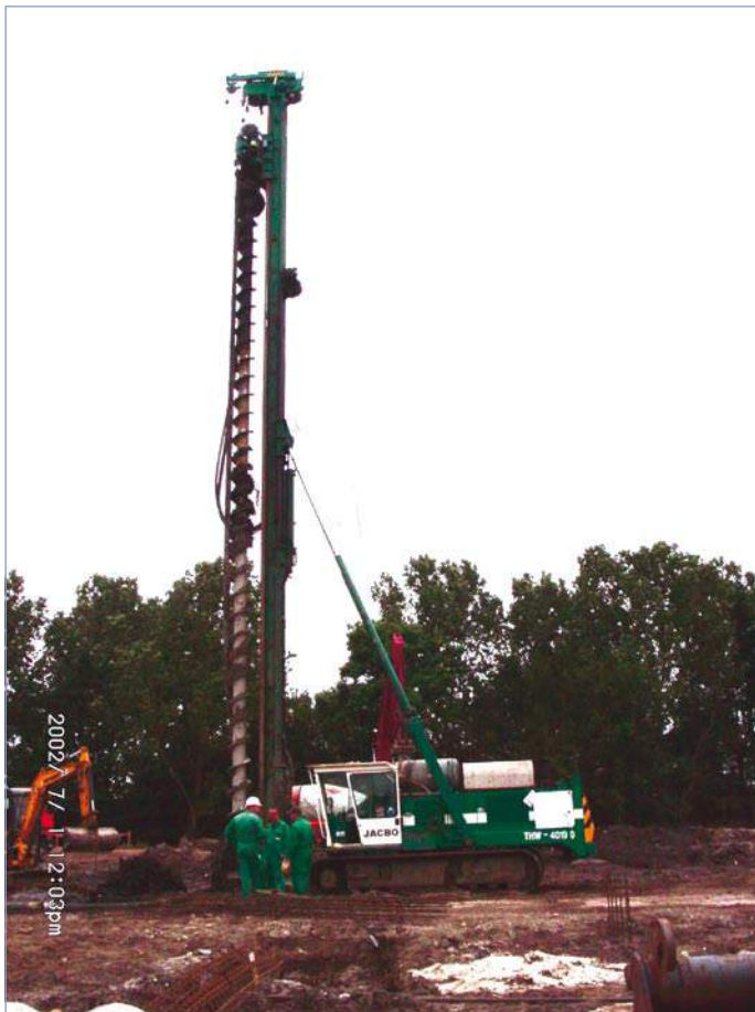
Abbildung 11: Bohrung einer Grundwassermessstelle
