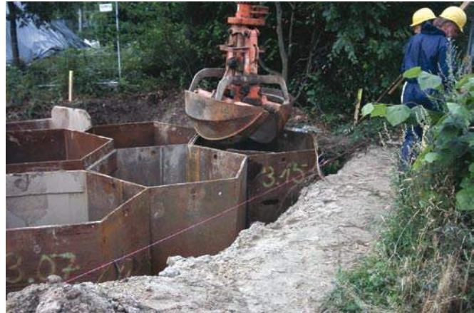
Abbildung 32: Sanierung der Schadensquelle durch Bodenaustausch im Schutz von Wabenprofilen
