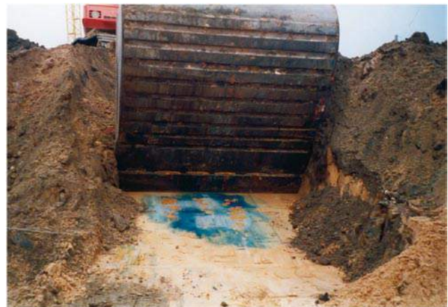
Abbildung 28: Bodenverunreinigung mit Cyanid (Berliner Blau)
