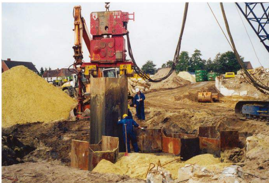
Abbildung 31: Einbringen von Wabenprofilen zum Bodenaustausch
