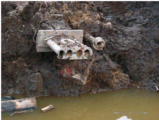
Abbildung 19: Erdverlegte Kraftstoffleitungen einer ehemaligen Tankstelle
