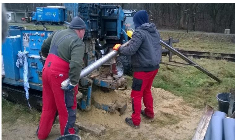
Abb. 9: Entnahme Kernrohr
