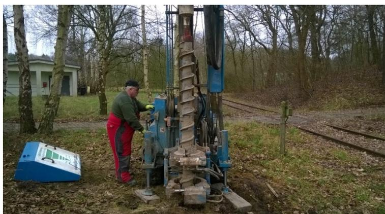
Abb. 8: Bohrgerät mit Hohlbohrschnecke
