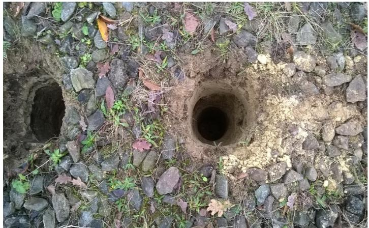
Abb. 5: Vorkernen und Vorschachten der Bohransatzpunkte
