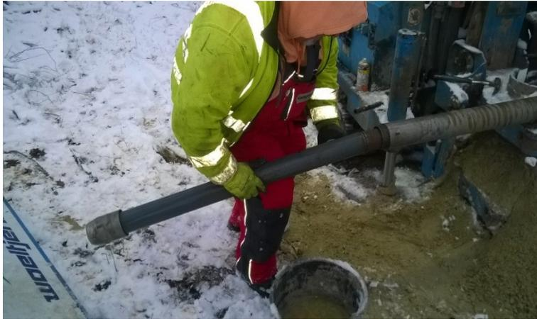
Abb. 10: Entnahme Liner
