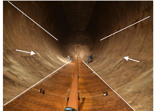
Zementbeschichtung auf Tankinnenwand bis etwa 6,0 m lichter Höhe.
