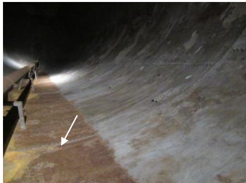
Entfernte Zementbeschichtung im Niveau der Tanksohle (ca. 2,5 lfm).
