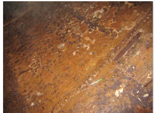
Zementbeschichtung (hellbraun) mit Fehlstellen (dunkelbraun).
