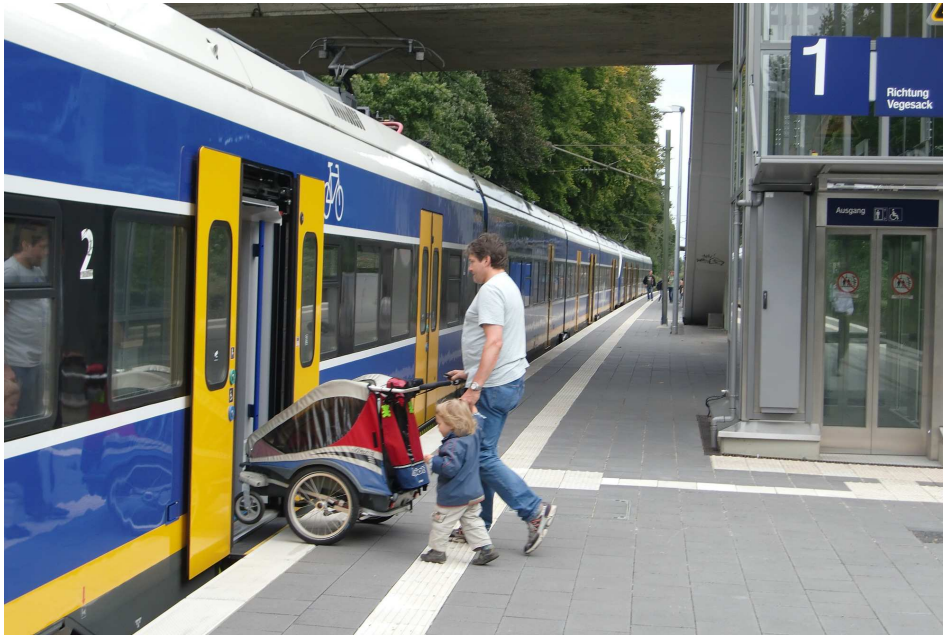
Abb. 2: Beispiel einer modern gestalteten, barrierefreien Station mit einfachem Zugang zu den Fahrzeugen: Bremen-St. Magnus (Foto: Agentur BahnStadt, Berlin)
