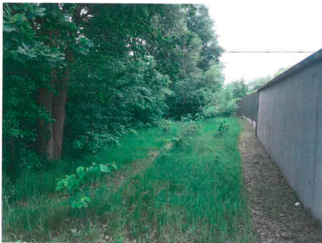
Foto 4: Blick auf die Nordseite des Testfeldes von Osten nach Westen; Rechts: Lärmschutzwand B 74
