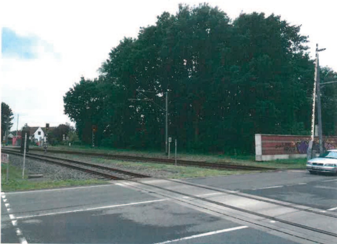
Foto 8: Blick von Nordosten nach Südwesten auf den Bereich des Testfeldes, davor B 74
