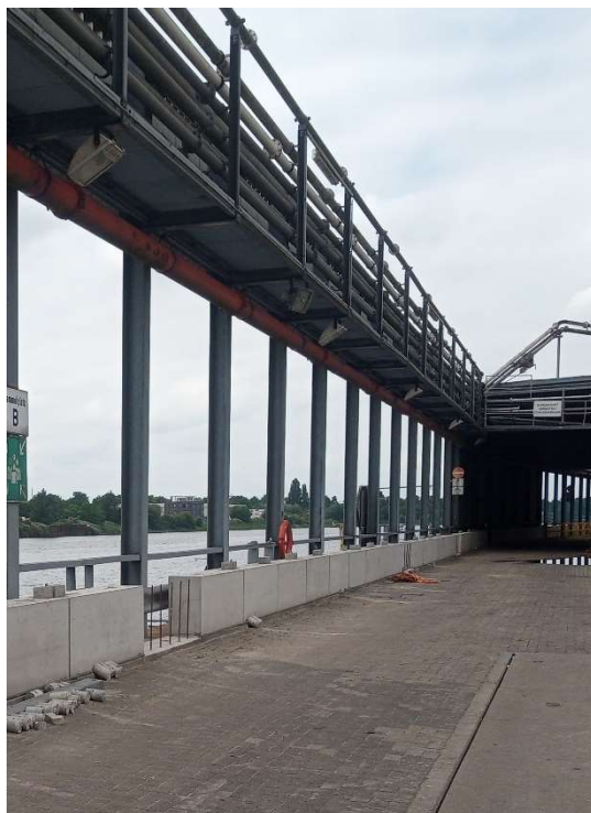
Abbildung 17: Rohr- und Förderbrücke auf Kajenholm mit einer Stützenachse, Foto IL am 23.06.21 (rechts), und Querschnitt mit Maßen, Auszug aus der Bauakte [U.4] (links)
