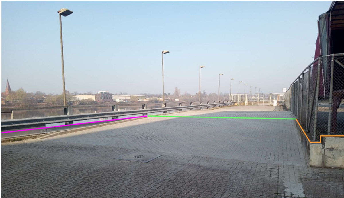
Abbildung 12: Hochwasserschutzanlage als Aufpflasterung / Rampe mit HWS-Linie (Markierung vgl. Abbildung 4), Foto IL vom 25.03.22
