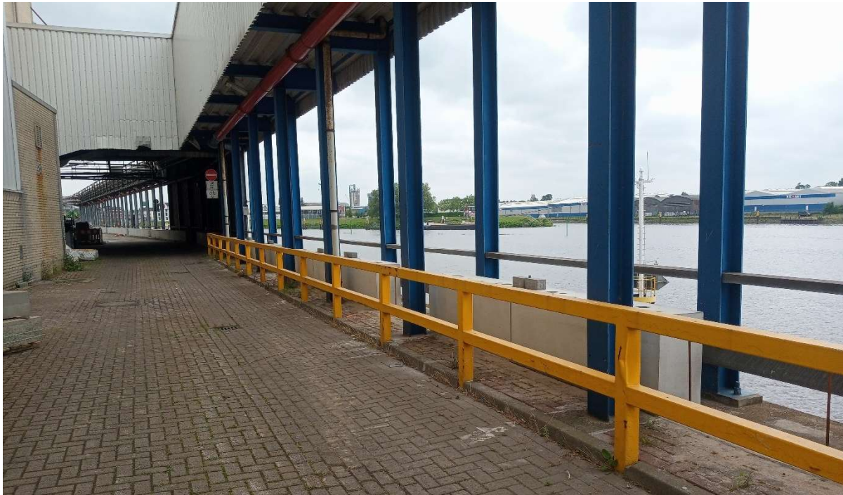
Abbildung 18: Rohr- und Förderbrücke auf Kajenholm mit zwei Stützenachsen und Schutzzaun, Foto IL am 23.06.22
