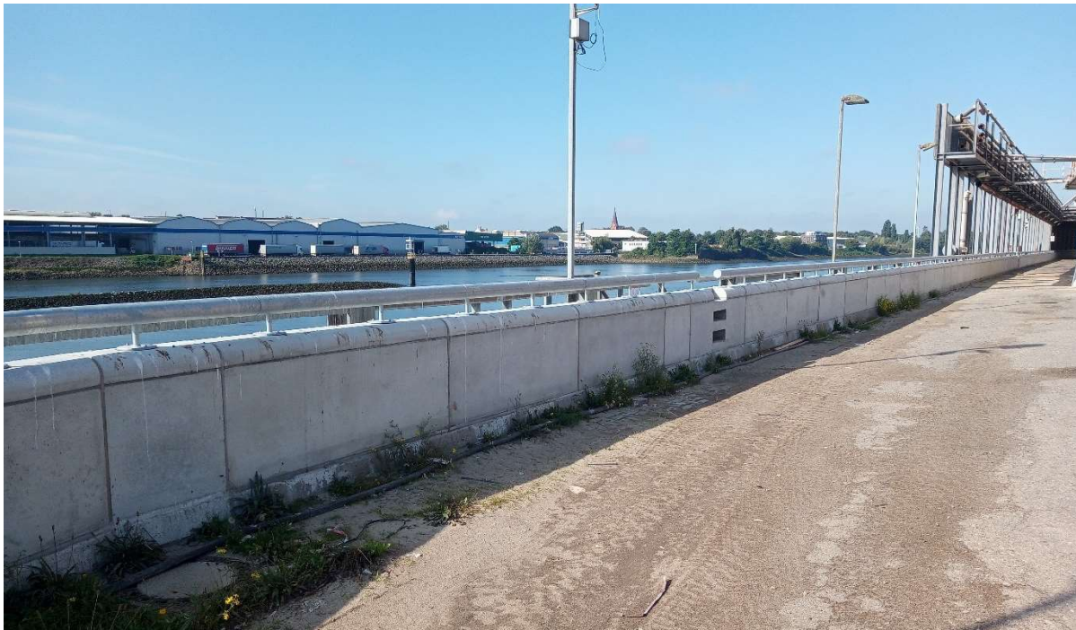
Abbildung 6: Hochwasserschutzanlage als Stahlbetonmauer mit Geländer, Foto IL vom 28.09.21
