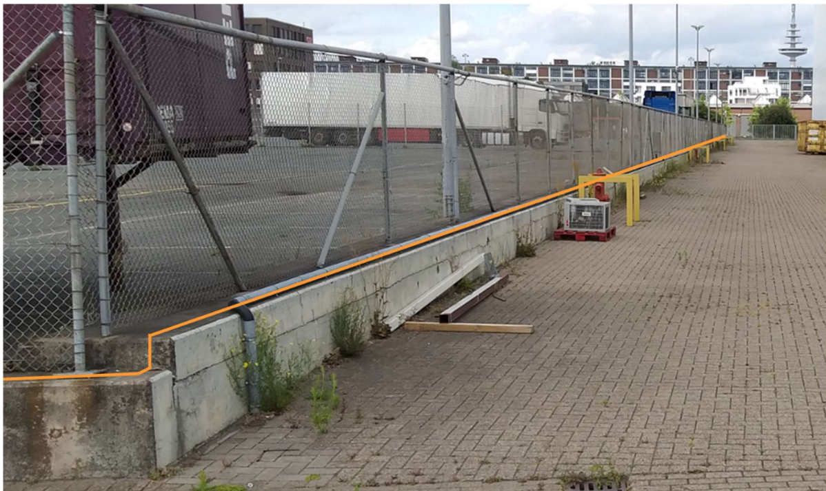
Abbildung 14: HWS-Linie auf der Mauer am westlichen Parkplatz in orange, Foto IL vom 04.07.2019
