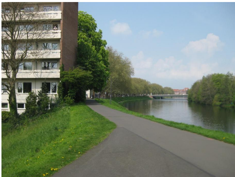
Abbildung 2-8: Deichlinie südlich der Wilhelm-Kaisen-Brücke (Blickrichtung Nord)
