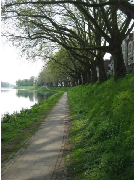
Abbildung 2-7: Deichlinie südlich der Wilhelm-Kaisen-Brücke (Blickrichtung Süd)
