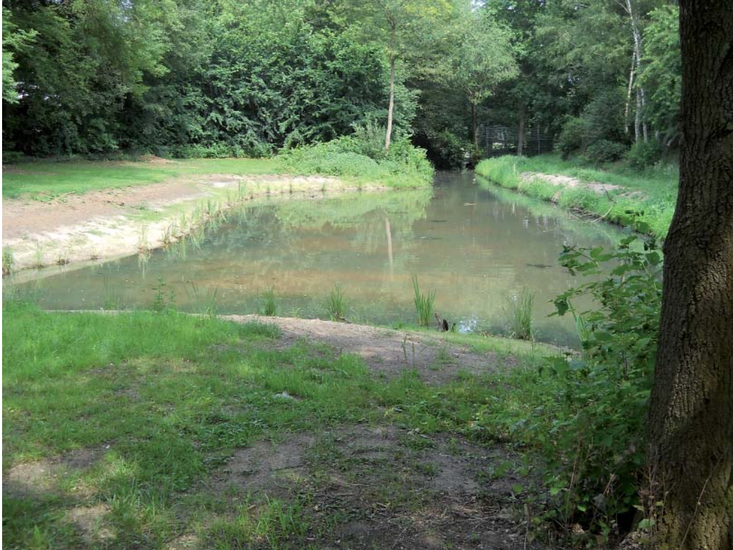
Die naturnahen Regenrückhaltefläche mit Initialbepflanzung unmittelbar nach der Baumaßnahme im Juni 2011
