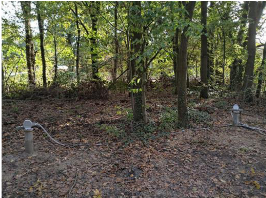
Abbildung 11: Neu erstellte Grundwassermessstellen IB2 (links) und IB1 (rechts)
