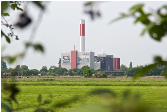
Abfallheizkraftwerk der BEG
