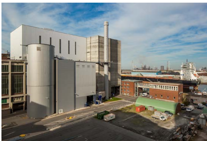
Mittelkalorik-Kraftwerk der swb
