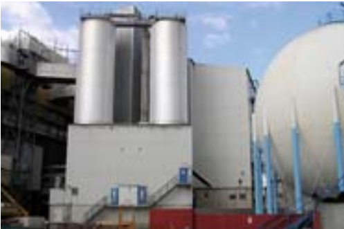
Fast schon eine Chemiefabrik: Sicherstellung der Rauchgasreinigung am MHW Bremen
