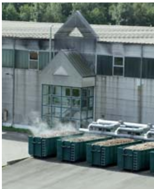
Verwertung mit Abgasen: Reinigung in den Biofiltern der Bioabfallkompostierungsanlage in Bremen
