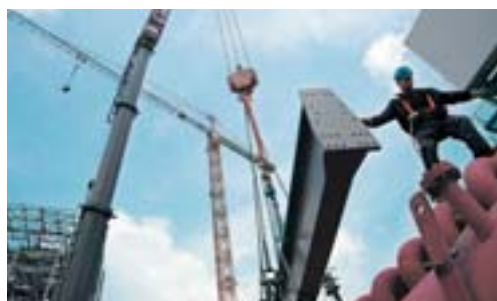
Noch ein Träger, dann ist es geschafft: Umbauarbeiten am MHW Bremen 2004
