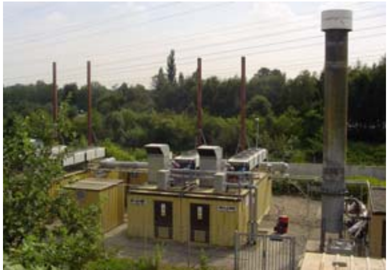
Verwertung mit rückläufiger Tendenz: Deponiegasmotoren auf der Blocklanddeponie
