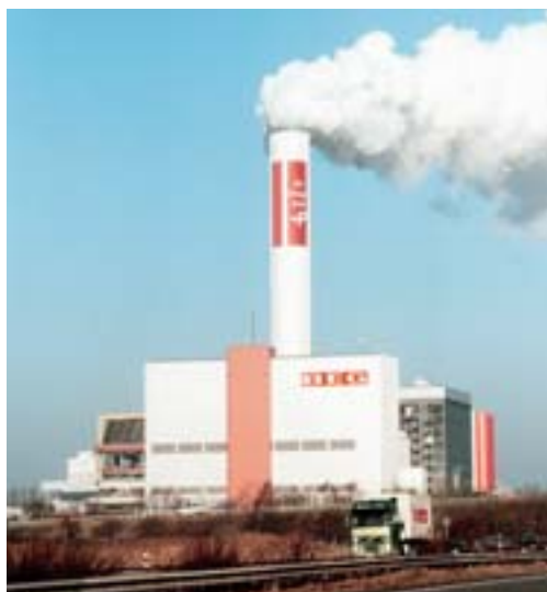
Hier wird nicht nur heiße Luft produziert, sondern auch Strom und Wärme: MHKW in Bremerhaven
