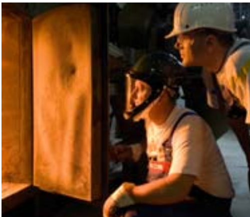
Ein heißer Anblick: Der Verbrennungsrast im MHW Bremen
