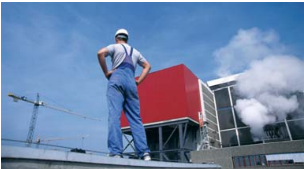
Blick in eine gesicherte Zukunft der Abfallentsorgung: Umbauarbeiten am MHW Bremen 2004
