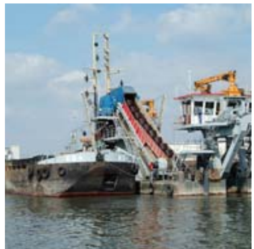
Damit „de Werser geht“: Eimerkettenbagger von bremenports
