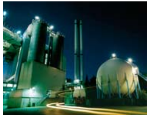
Auch bei Nacht: die Abgase des MHW Bremen müssen gereinigt werden
