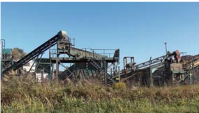
... und Förderbänder: Die Aufbereitungsanlage für MVA-Aschen und Schlacken der Optima-Entsorgungs-GmbH in Bremerhaven
