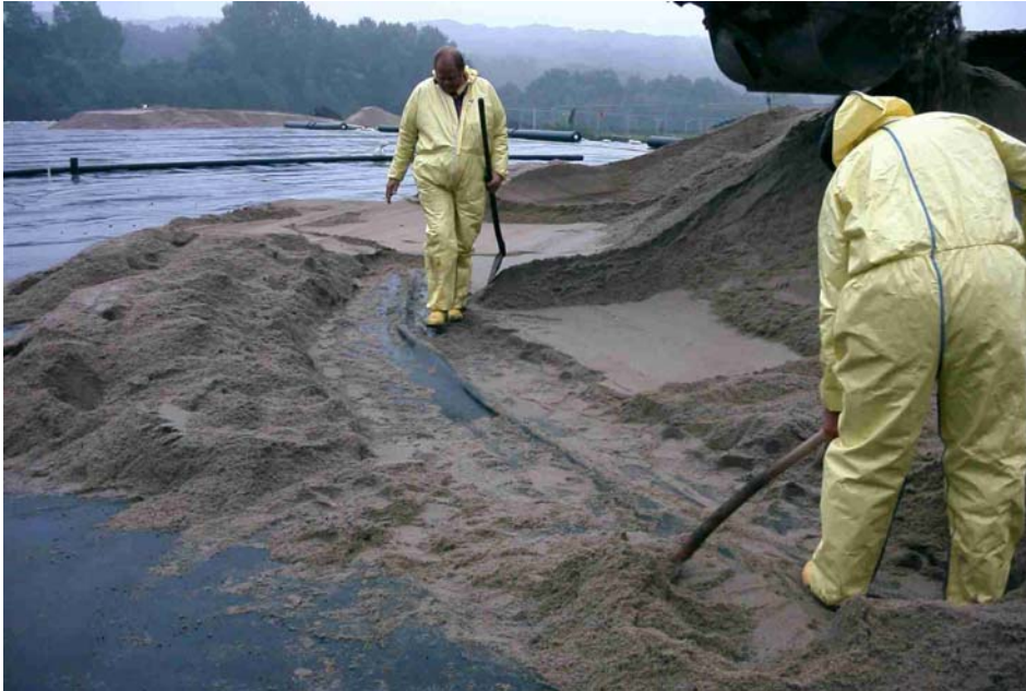
Abb. 2: Erstellung der Oberflächenabdichtung einer Altablagerung
