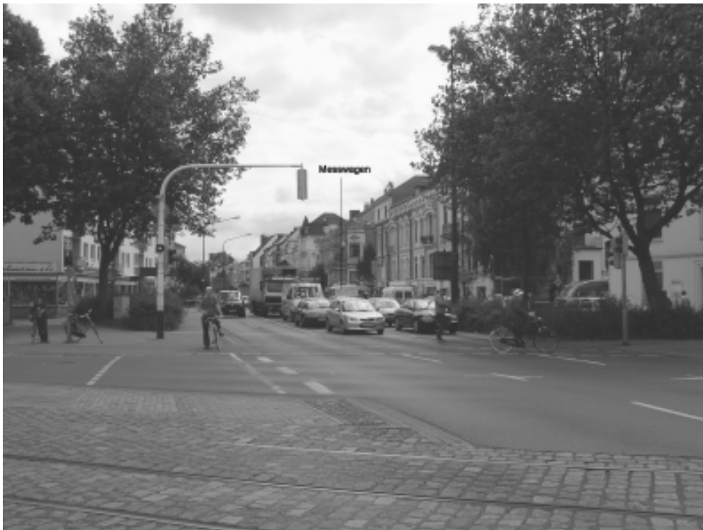
Abb. 2.3: Blick Richtung Osten in die Bismarckstraße mit Messwagen
