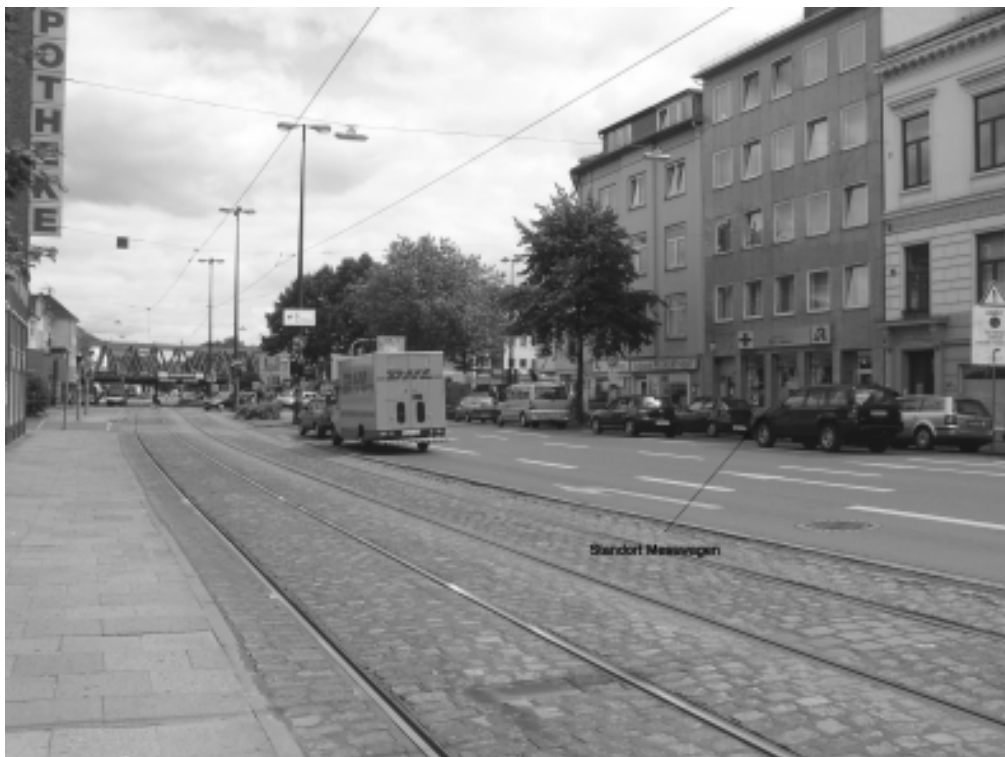
Abb. 2.4: Blick Richtung Nordosten im Dobbenweg mit Angabe des Standorts des Messwagens während der temporären Messungen
