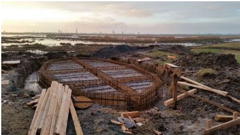
Abb. 3: Baustelle des Fundamentes vom Beobachtungsturm. (Foto: L. Achilles)
