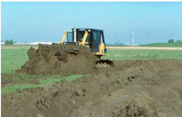
Foto 4: Baumaßnahmen Spülfeld Nord (Okt. 1996)
