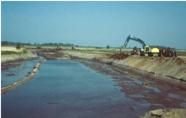
Foto 2: Baumaßnahmen am Nordpriel-Eingang (Juli 1997)
