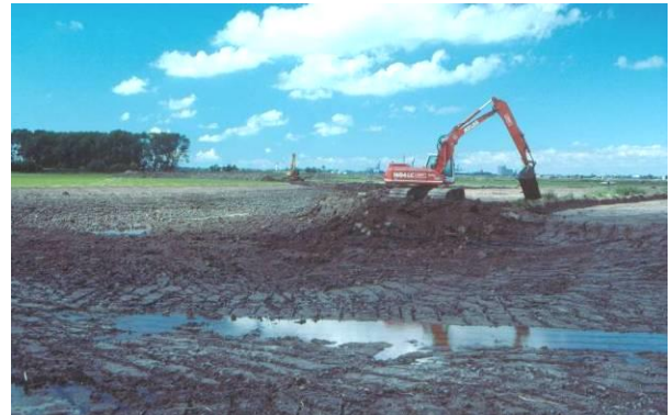
Foto 3: Baumaßnahmen am Südpriel im Bereich der Verzweigung (Juni 1997)
