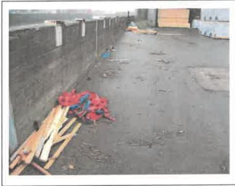
Zwischen den Stationen 102,80 - 114,30 und 118,80 - 125,00 ist die HWS-Wand auf einer Länge von insgesamt rd. 100 m als Gießständerkonstruktion mit Dammbalkentafeln ausgebildet (s. nebenstehende Abbildung). Die Dammtafeln aus Holz sind dauerhaft eingesetzt und werden ausschließlich für die Dauer von Schiffsbe- und Schiffsentladevorgängen gezogen.
