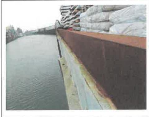
Die Südseite des Holz- und Fabrikenhafens ist über weite Strecken durch eine ufernahe Bebauung geprägt. Aufgrund der beengten Situation ist kein durchgängiger Deichverteidigungsweg vorhanden. Die Zuwegung und Unterhaltung der Hochwasserschutzanlage sind aus diesen Gründen stark eingeschränkt.
