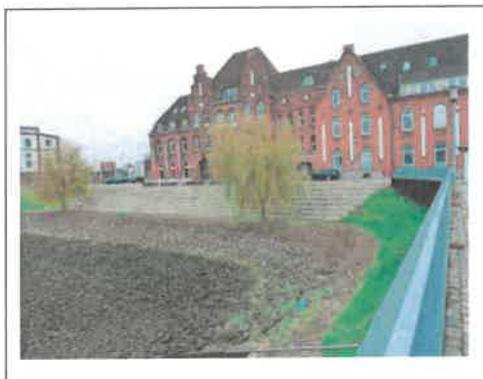
Vor Kopf des Hafens ist eine Treppenanlage mit Sitzstufen, Baujahr 2009/2010, in die Böschung integriert (s. nebenstehende Abbildung). Die Stufenanlage ist flach gegründet und die Stufenelemente wurden als Stahlbetonfertigteile ausgeführt. Die anschließende HWS-Wand im Anschlussbereich ist bereits ausreichend dimensioniert.
