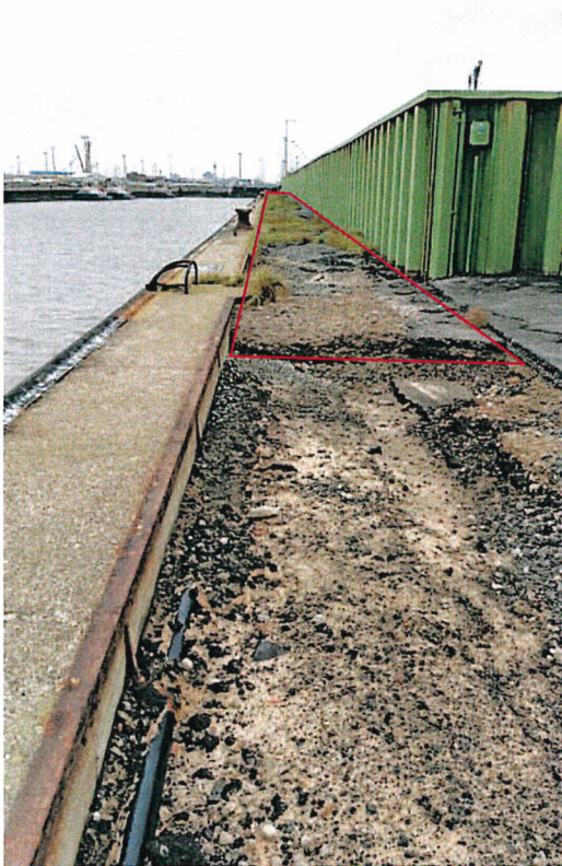
Foto 3: Überblick über die Teilfläche 8; Oberflächenbefestigung aus RC- Materialien und Schotter (rote Markierung)
