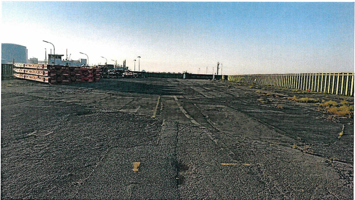
Foto 1: Foto 2: Überblick über die Fläche innerhalb der Bestandsspundwände mit Blick in Richtung Süden.
