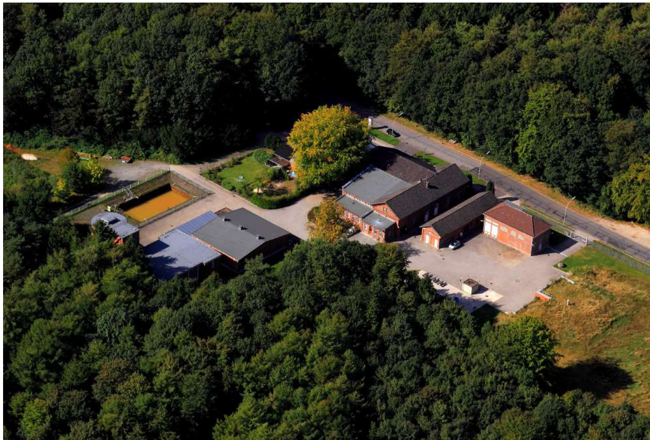
Wasserwerk Leherheide (swb AG)
