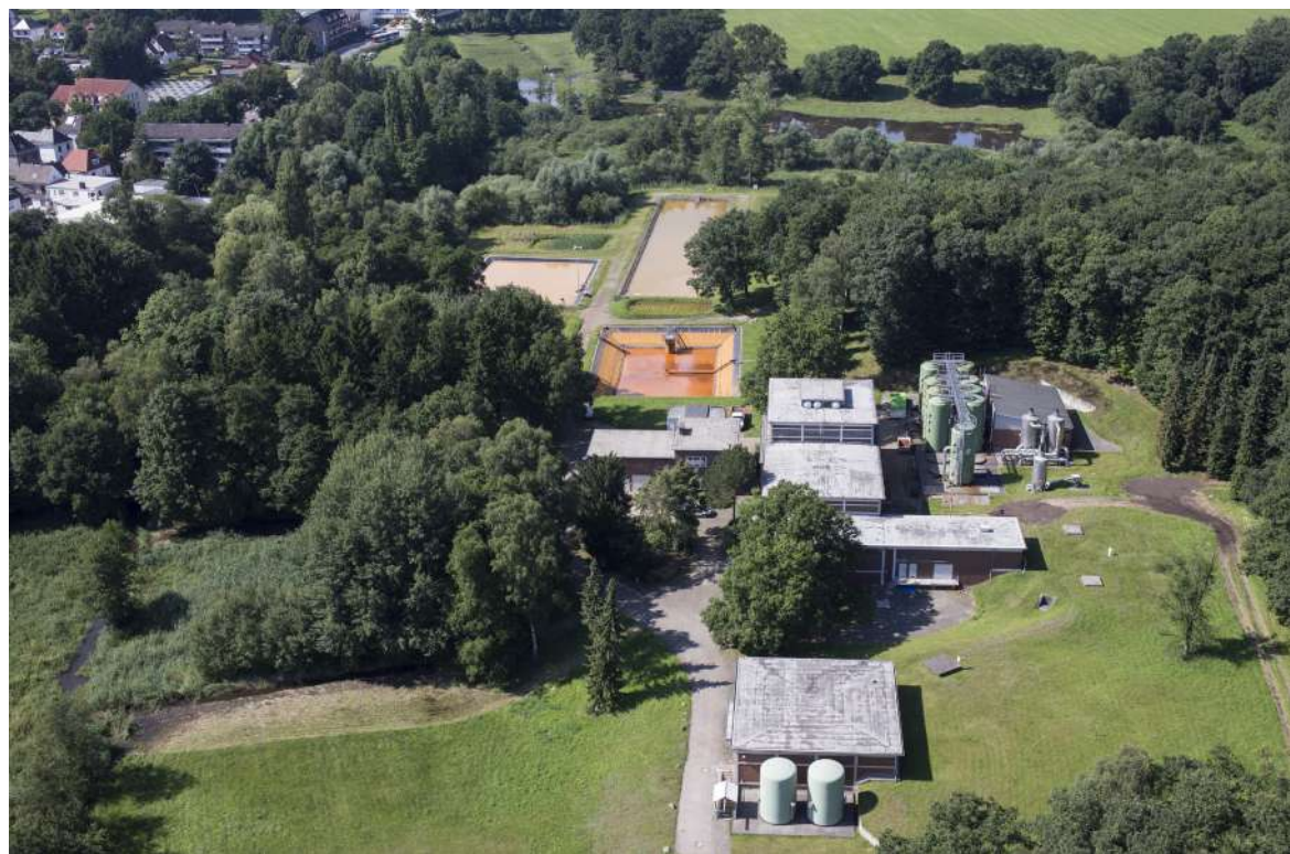
Wasserwerk Blumenthal (swb AG)
