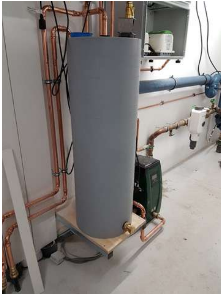
Grauwassernutzungsanlage im Wohnhaus (im Bauzustand, Quelle: BUB)
