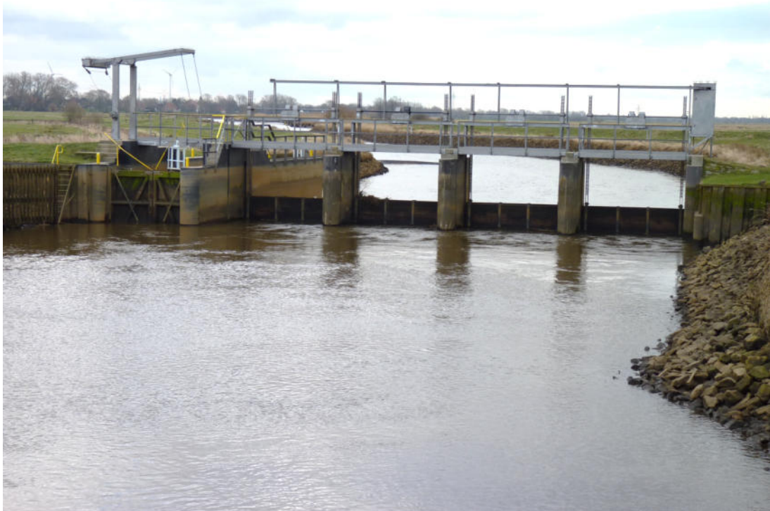
Abb. 4: Stauanlage in der Ochtum (Niedersachsen) von Unterstrom betrachtet. Linke Bildseite: Geschlossenes Schleusentor.
