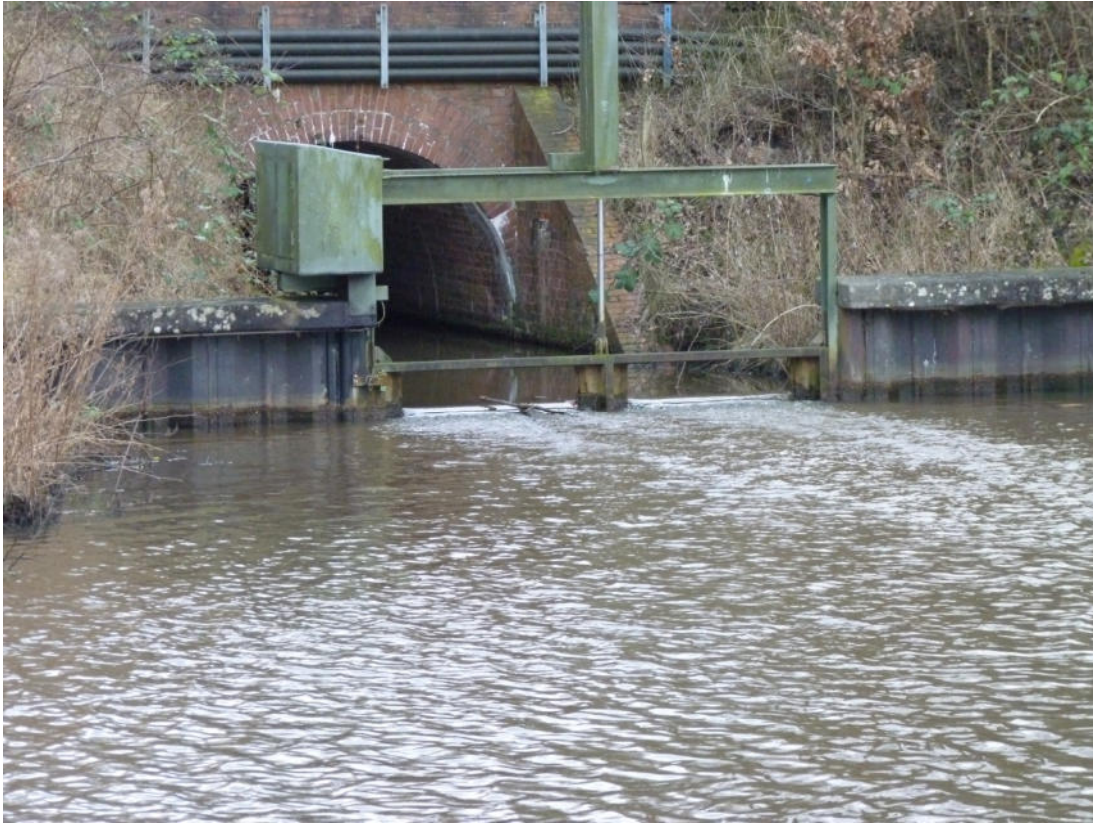
Abb. 19: Stauanlage an der Bahnlinie im Huchtinger Fleet
