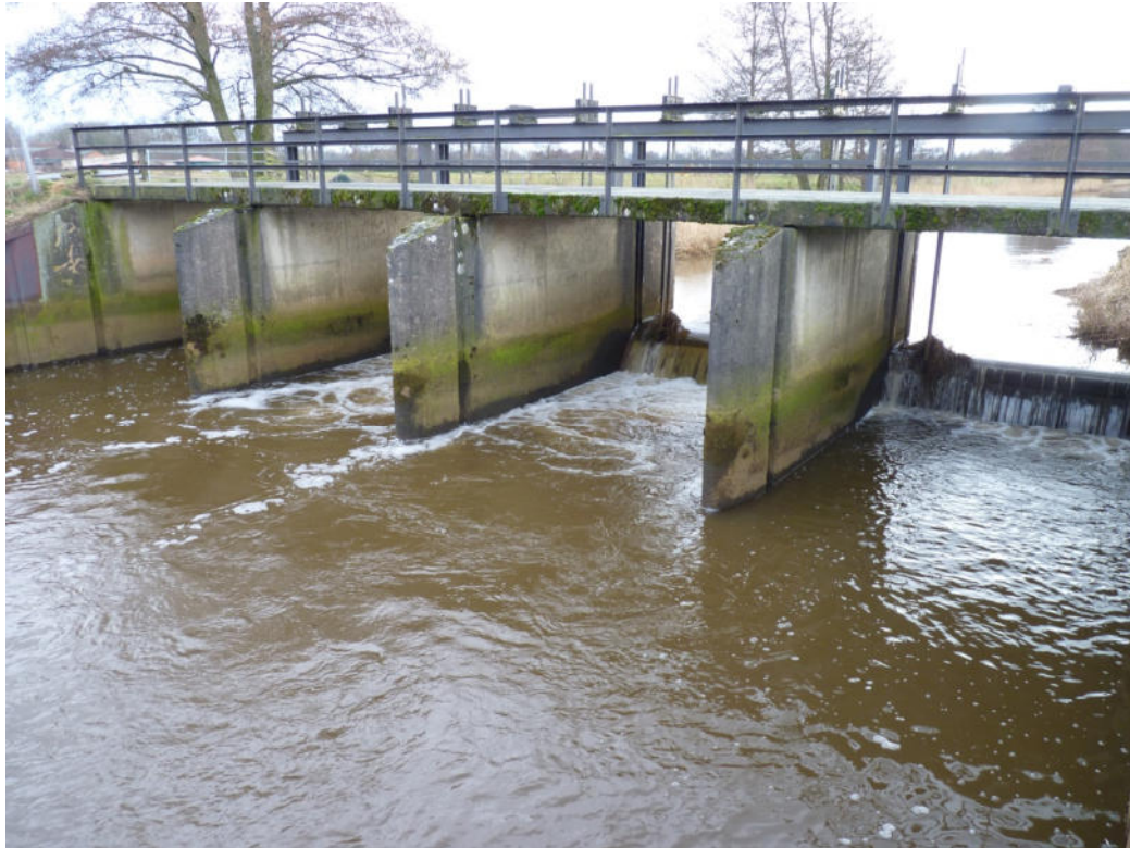
Abb. 7: Stauanlage Flügger (unterhalb des Bauwerks).
