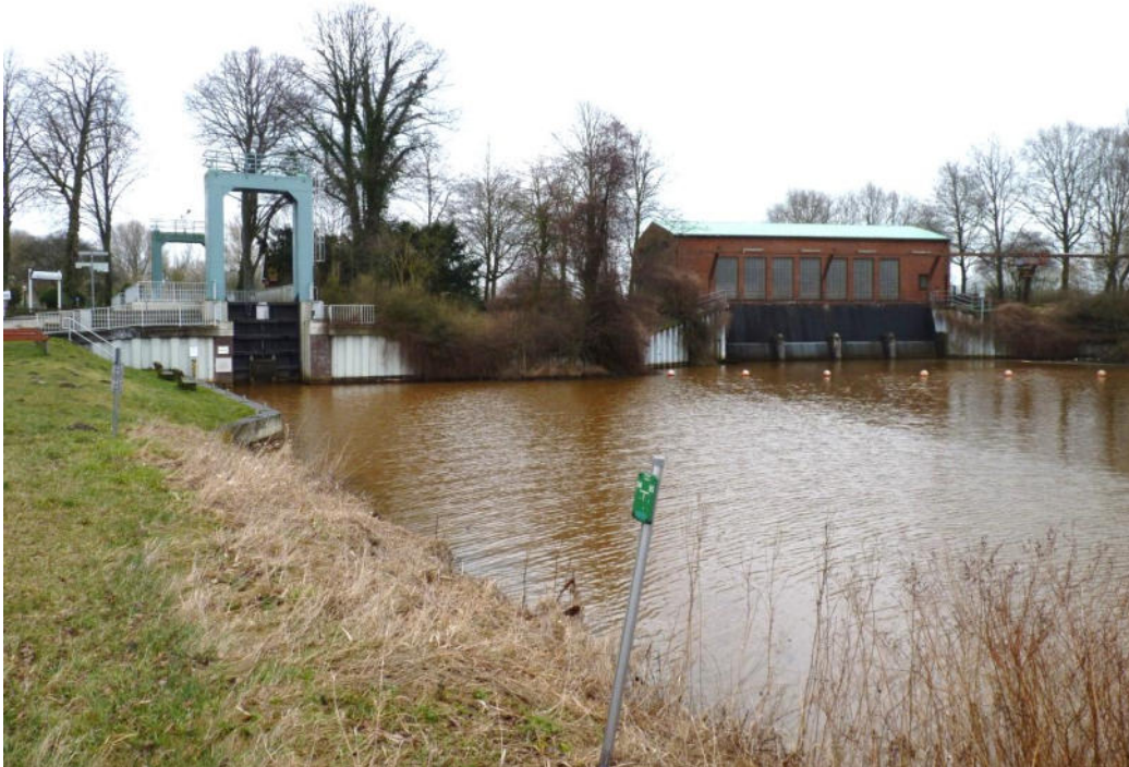
Abb. 16: Kuhsiel mit Schleuse von der Seite des Kuhgrabens.
