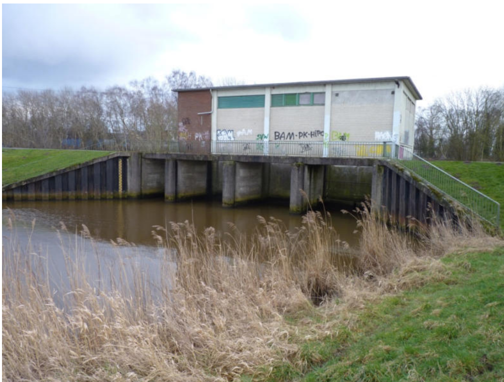
Abb. 17: Siel und Schöpfwerk Huchting von Seite des Huchtinger Fleet, außendeichs.
