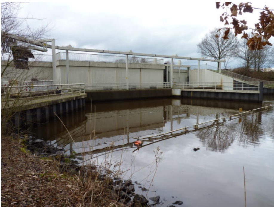
Abb. 15: Siel und Schöpfwerk Wasserhorst von der Seite des Maschinenfleets.
