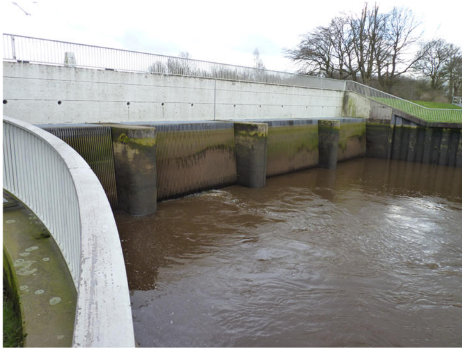
Abb. 14: Siel und Schöpfwerk Wasserhorst von der Lesumseite.
