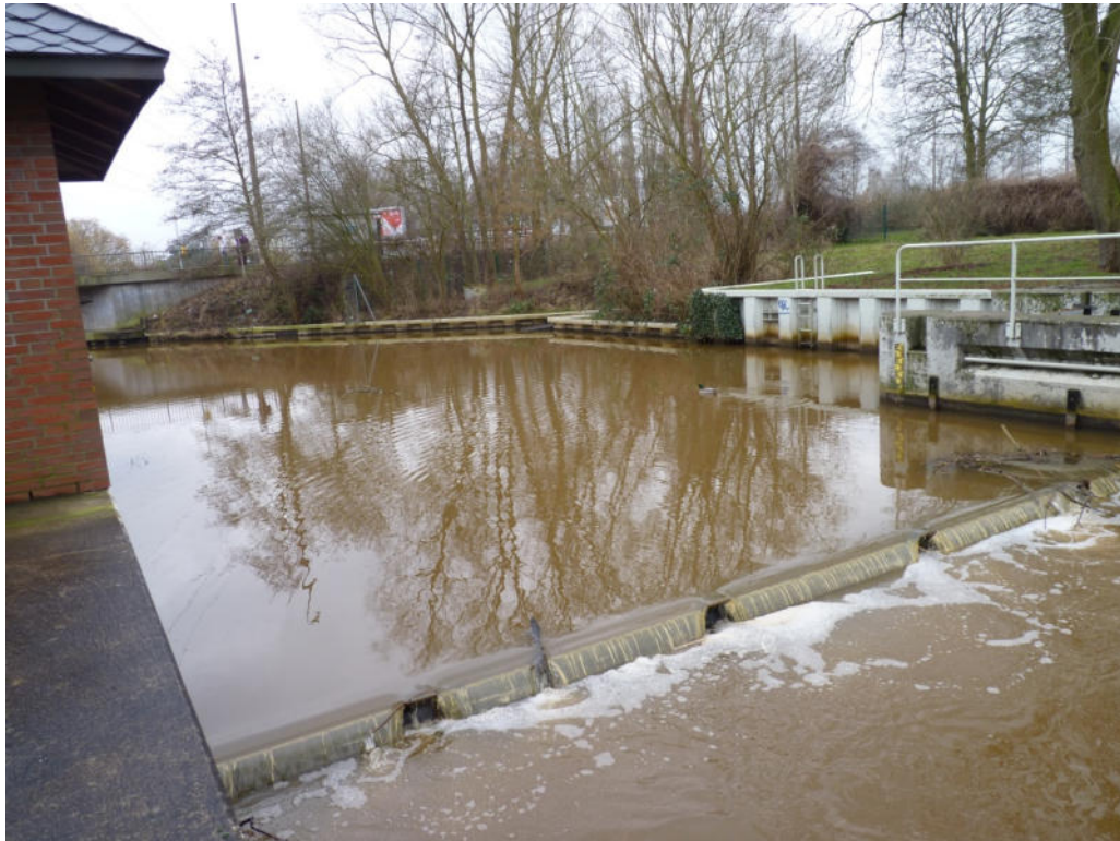
Abb. 12: Gehrkenstau (unterhalb des Bauwerks).
